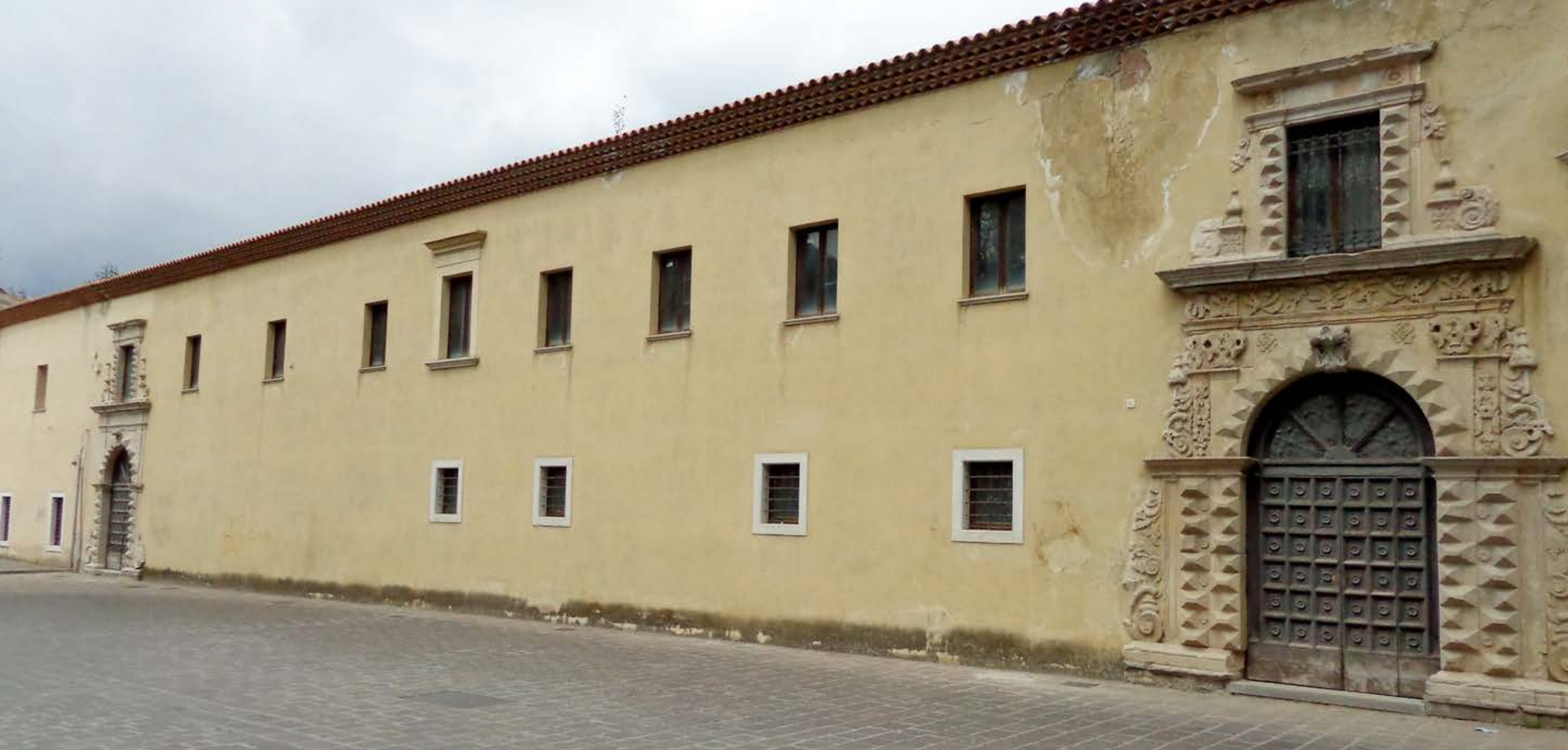
Prospetto principale dell'ex Monastero
