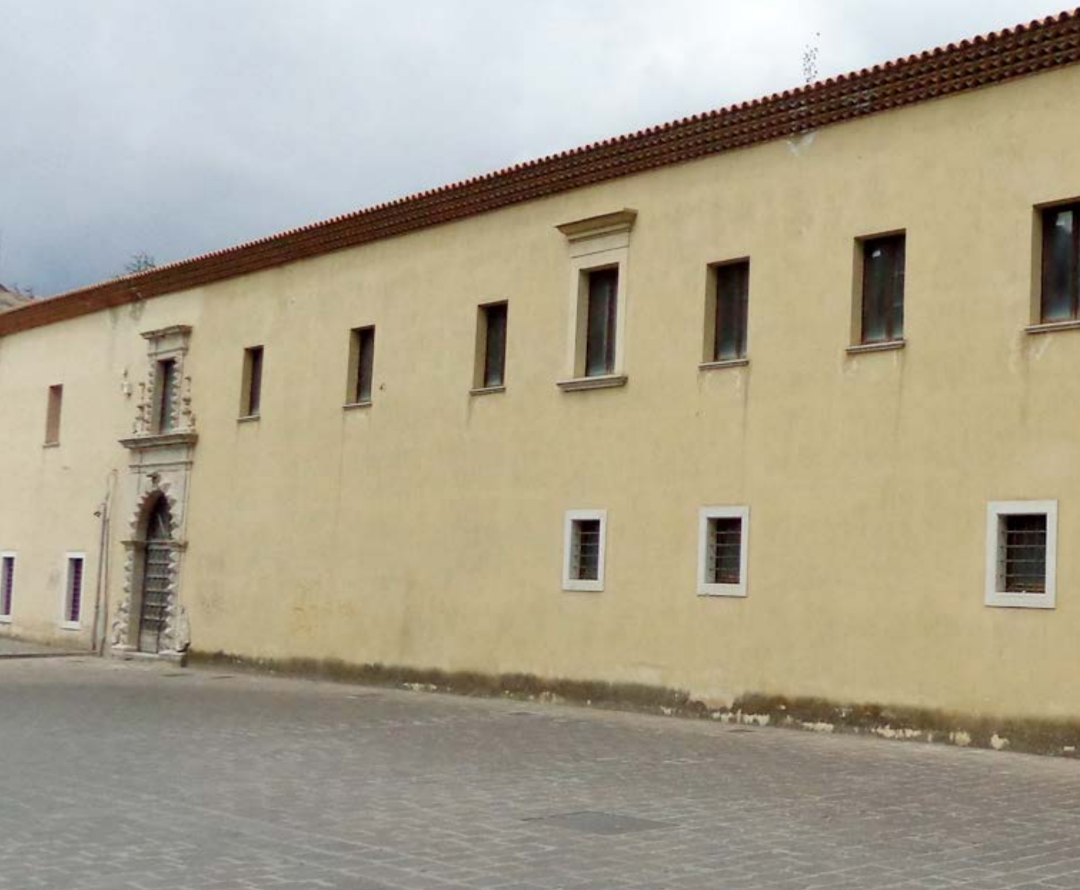
Prospetto principale dell'ex Monastero
