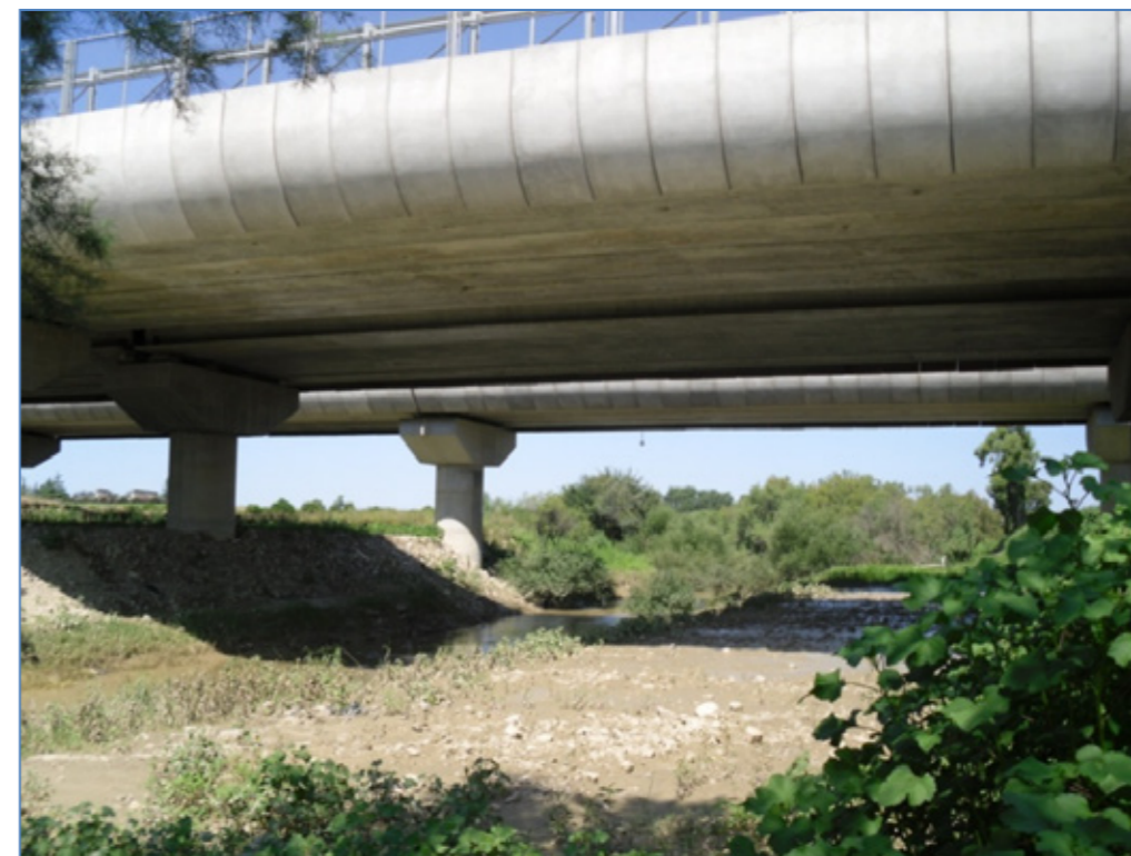
Figura 4.4. Attraversamento della Strada Statale 106 jonica sul fiume Bradano.
