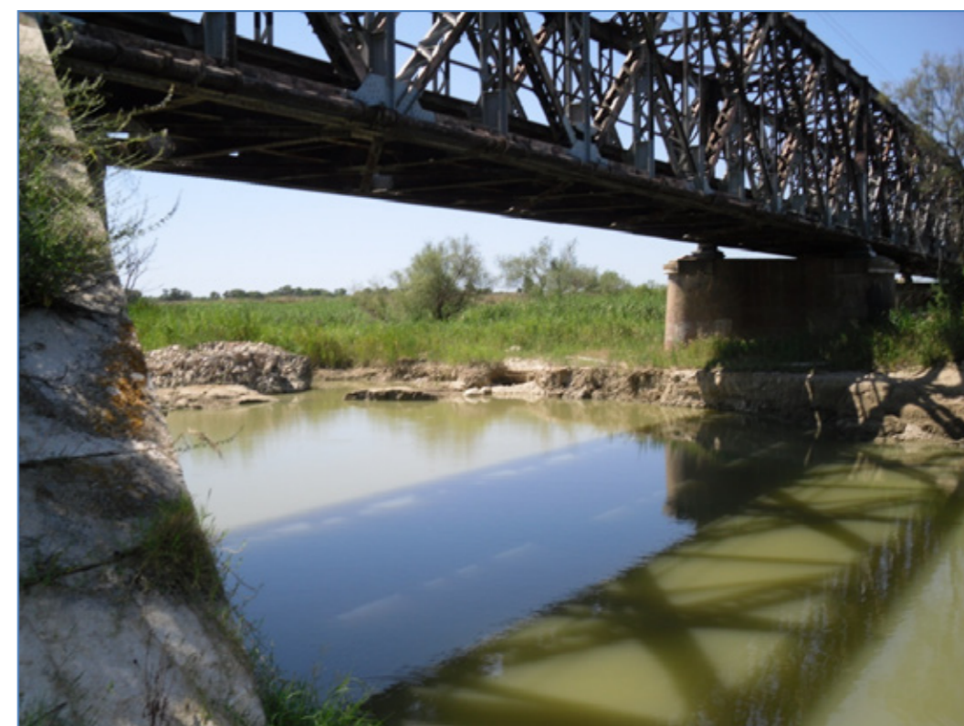
Figura 4.5. Attraversamento della linea ferroviaria Taranto-Reggio Calabria.
