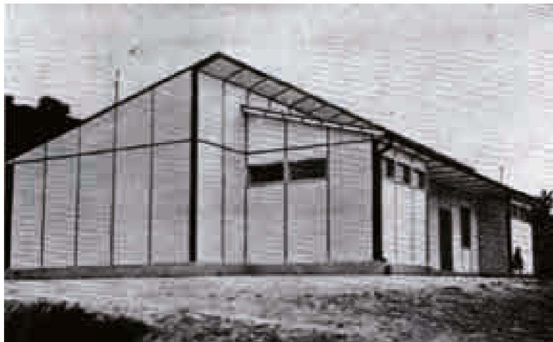
Fig.3.18 Scuola prefabbricata nel comune di Calciano.
