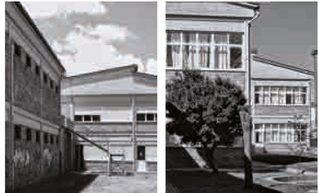
Fig 3.57 Foto della Scuola Elementare di Grassano, 2011. All'interno del complesso sono stati inseriti nuovi elementi ed eliminati altri: la scala di emergenza in acciaio che collega i piani superiori dei Blocchi aule direttamente con l'esterno. Le velette in cemento sono state rimosse..
