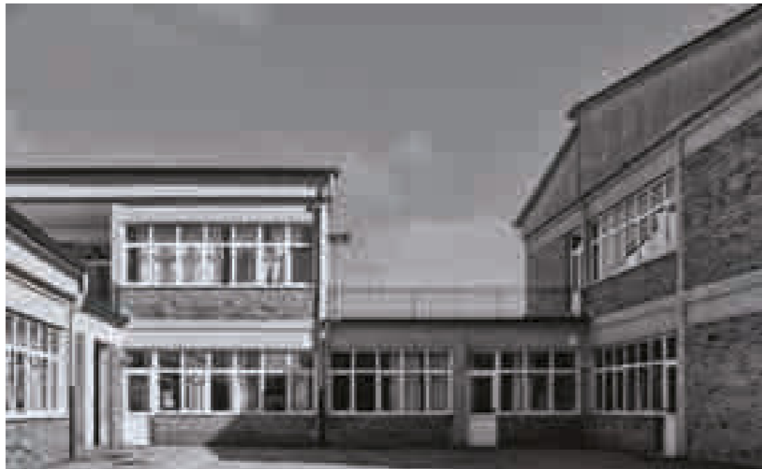
Fig 3.56 Foto della Scuola Elementare di Grassano, 2011. La vista riprende le strutture di collegamento tra i Blocchi aule, oggi trasformate in nuove aule.
