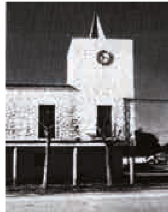
Fig.2.6 Edificio comunale del pueblo de Vegaviana 1954. Architetto: J. Luis Fernández del Amo
