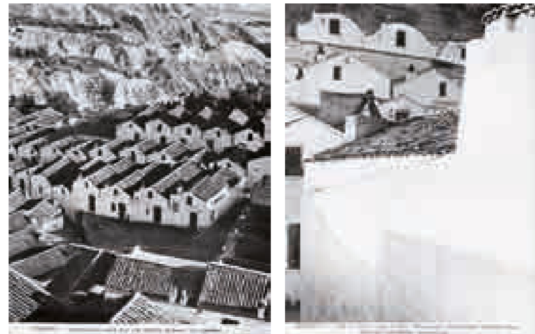
Fig.4.20-4.21 Fotografie con viste sulle abitazioni di Pisticci, pubblicate sul volume che raccoglie le indagini condotte a Grassano dalla Commissione parlamentare di inchiesta sulla miseria in Italia e sui mezzi per combatterla. 1953.
