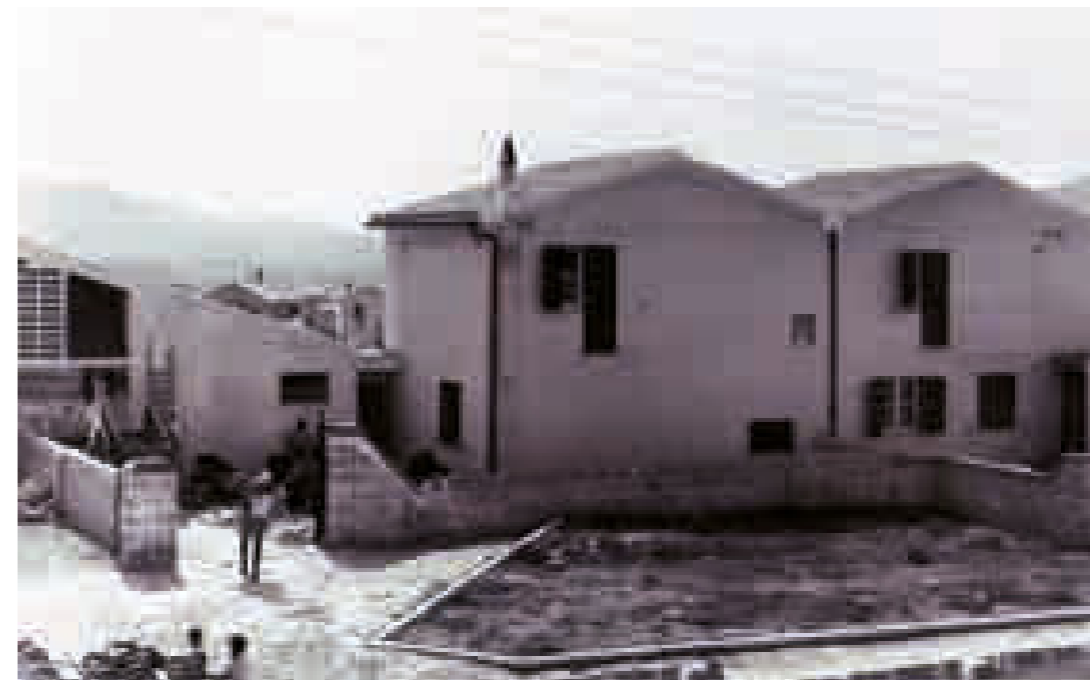
Fig.4.57 Veduta di una strada con le abitazioni per contadini. La foto è stata scattata a pochi anni dalla edificazione del borgo. Si possono ancora osservare gli interventi di manutenzione realizzati in copertura, con le nuove tegole di tono più chiaro e la soletta a sbalzo con l'intonaco appena realizzato.
