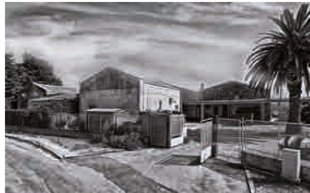
Fig 3.84 Foto dell'Istituto Professionale Agrario per il Borgo La Martella, 2011. La fotografia mostra la pensilina con l'ingresso secondario e la casa del custode sul fondo. L'edificio da diversi anni è occupato abusivamente e gli attuali abitanti hanno trasformato notevolmente gli spazi adattandoli ad abitazione.
