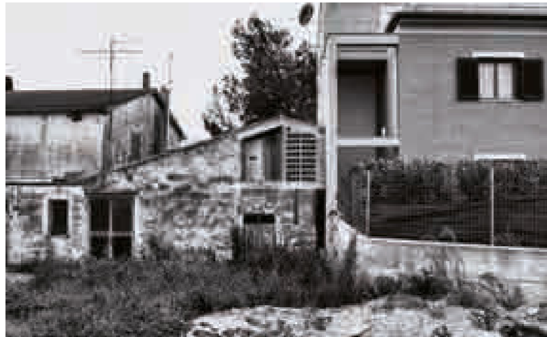
Fig.4.58 Esempio di demolizione totale e successiva costruzione di ordinaria edilizia nel borgo La Martella. La foto realizzata nel 2011, mostra il muro cieco di un edificio di nuova realizzazione posto in aderenza alla stalla di una abitazione per contadini.
