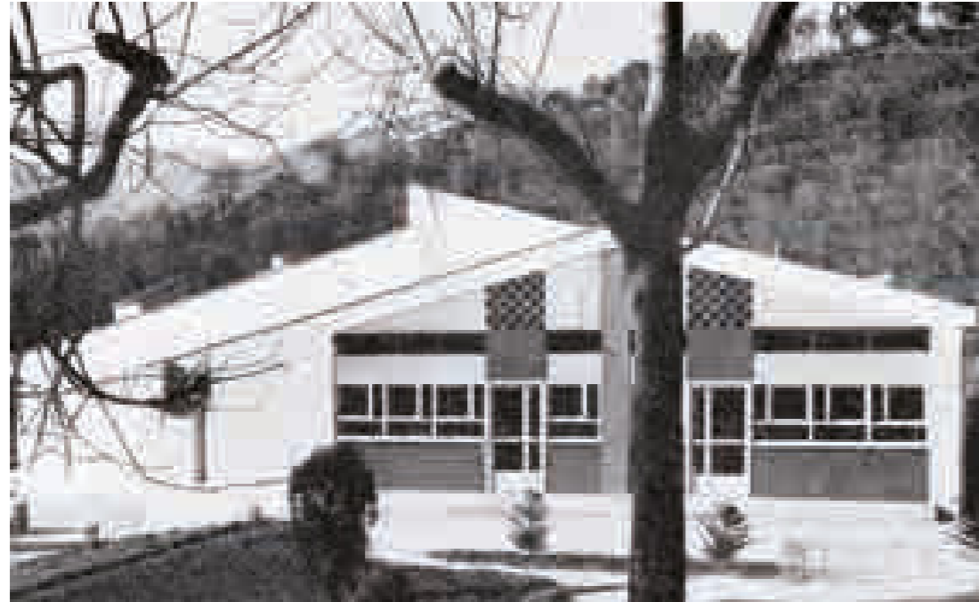
Fig.1.21 Scuola elementare a Dupino di Cava de Tirreni, architetto Diambra De Sanctis, 1956. Esempio di unità funzionale a 5 aule realizzata nel salernitano e donata agli alluvionati. Il progetto di questa ed altre scuole, furono elaborate dai tecnici del Centro Studi e raccolte nel volume 4 dei Quaderni uscito nel 1957.
