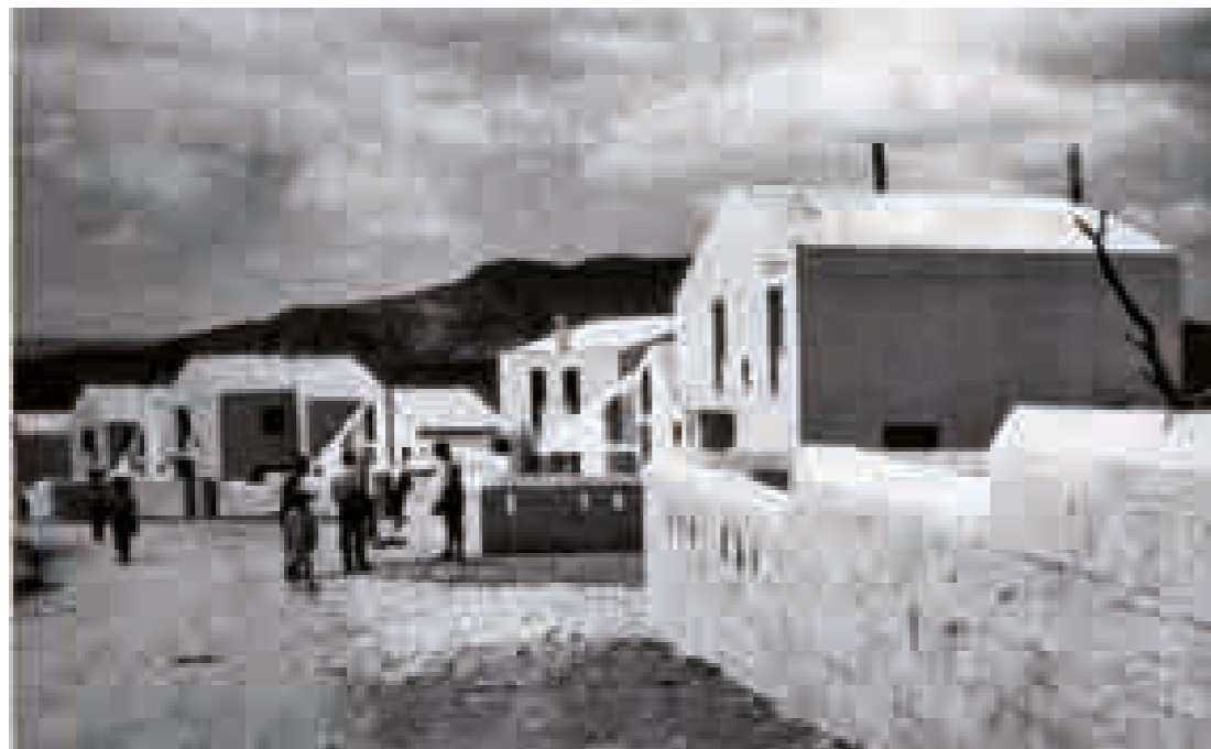
Fig.4.56 Veduta di una strada con le abitazioni per contadini appena realizzate. In primo piano il muretto in tufo che delimita le proprietà del villaggio. Borgo La Martella, 1951-54; Progetto Quaroni, Gorio, Valori, Lugli, Agati.
