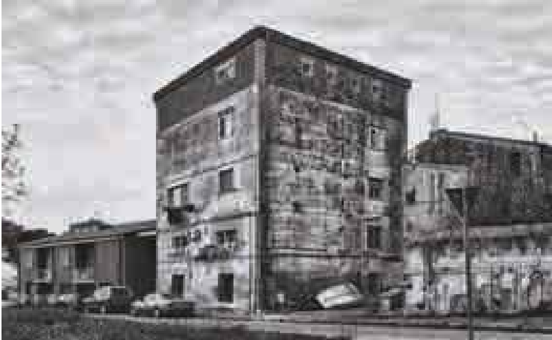
Fig.1.45 Borgo La Martella edificio assistenza, oggi trasformato in abitazioni.
