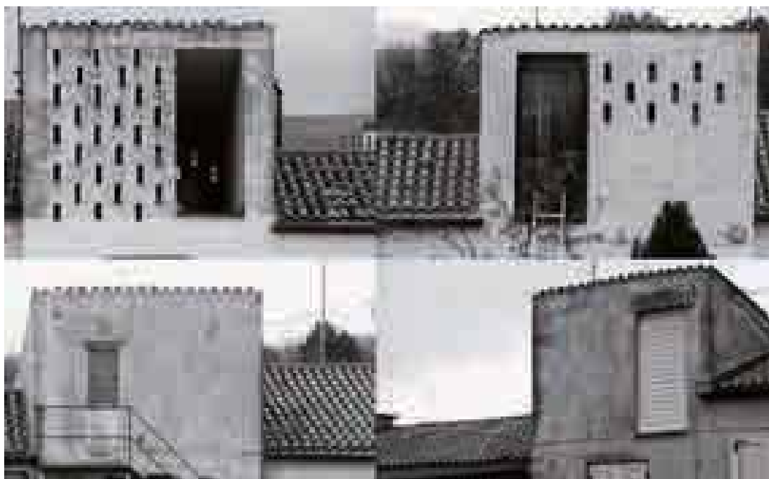
Fig.1.44 Granai del Borgo Venusio, nuove trasformazioni del vano.
