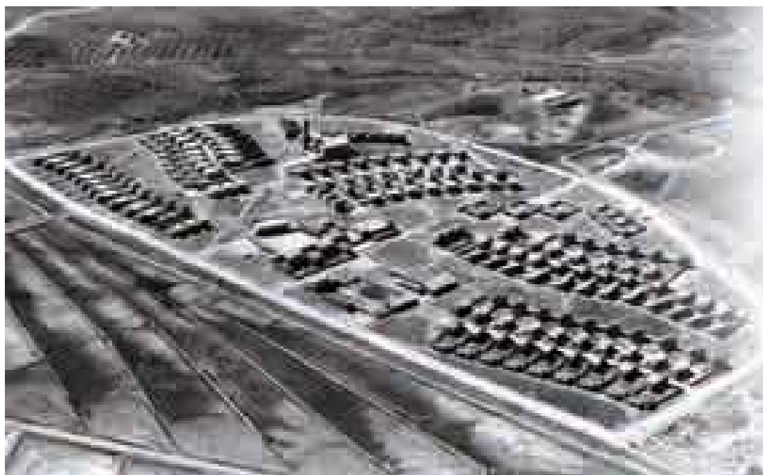
Fig.2.25 Foto aerea del pueblo de Cañada del Agra, Architetto: J. Luis Fernàndez del Amo.
