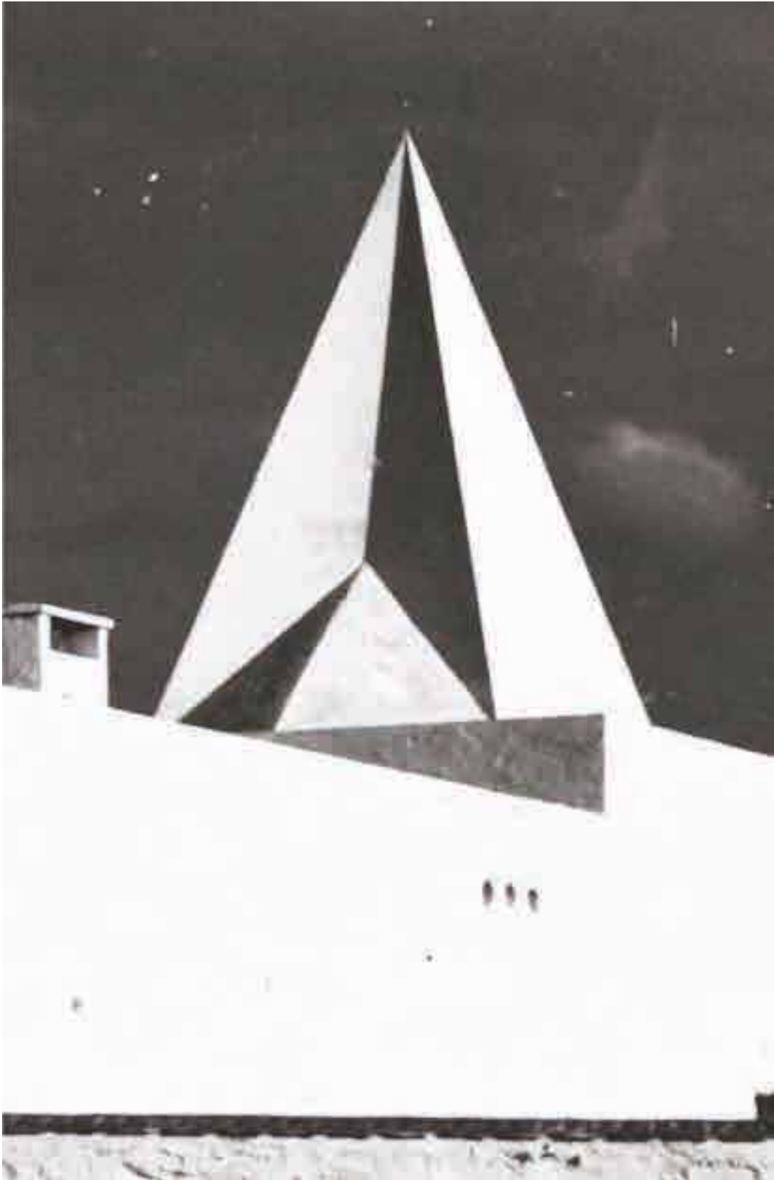
Fig.2.1 Scuola elementare del pueblo de San Isidro de huércal-Overa (Almería). Dettaglio del pinnacolo piramidale. Pueblo realizzato dall'Instituto Nacional de Colonización, progetto di J. Luis Fernández del Amo
