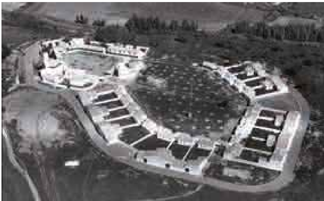
Fig.2.5 Pueblo de Colonización La Vereda Zona del Bembezar, Sevilla 1963. Architetto: J. Luis Fernàndez del Amo
