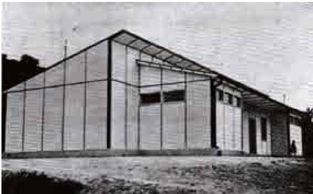
Fig.3.18 Scuola prefabbricata nel comune di Calciano.
