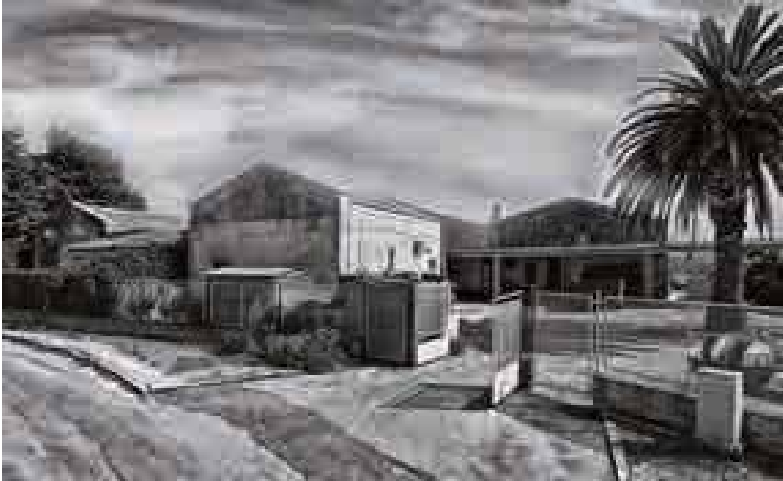
Fig 3.84 Foto dell'Istituto Professionale Agrario per il Borgo La Martella, 2011. La fotografia mostra la pensilina con l'ingresso secondario e la casa del custode sul fondo. L'edificio da diversi anni è occupato abusivamente e gli attuali abitanti hanno trasformato notevolmente gli spazi adattandoli ad abitazione.
