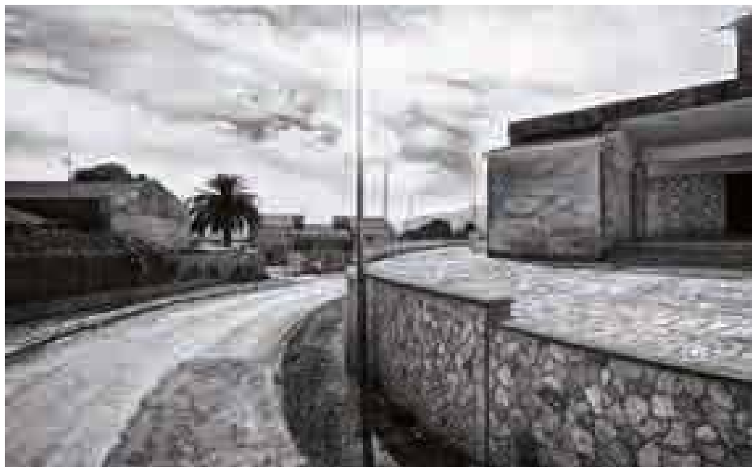
Fig 3.83 Foto dell'Istituto Professionale Agrario per il Borgo La Martella, 2011. Nell'immagine si può notare l'edificio scolastico sulla sinistra e le abitazioni insegnanti nel centro, sulla destra il sagrato della chiesa di S. Vincenzo de' Paoli, progettata anch'essa da Ludovico Quaroni.
