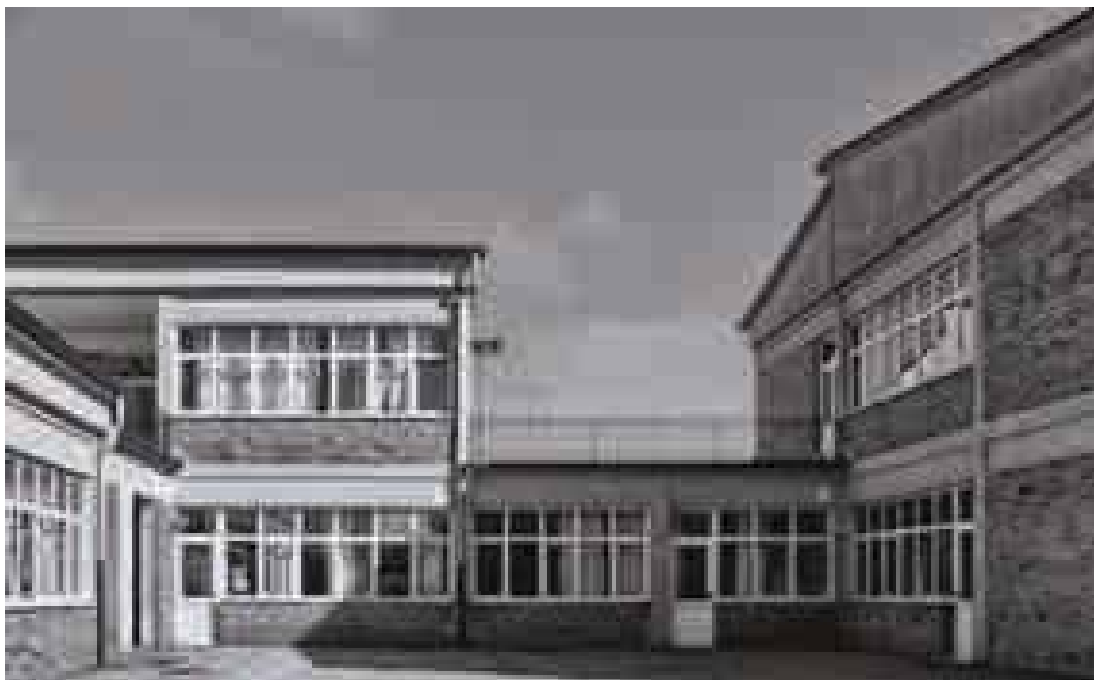
Fig 3.56 Foto della Scuola Elementare di Grassano, 2011. La vista riprende le strutture di collegamento tra i Blocchi aule, oggi trasformate in nuove aule.
