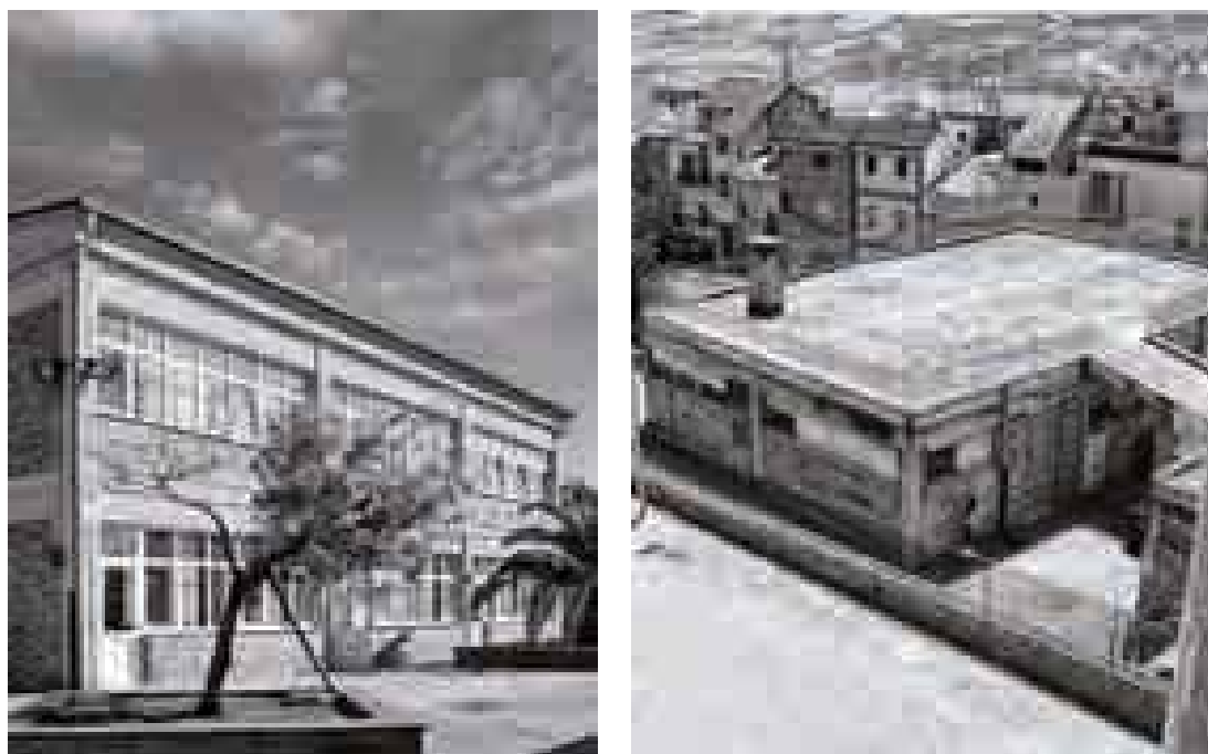
Fig 3.58 Foto della Scuola Elementare di Grassano, 2011. Nuovi infissi hanno sostituito i vecchi serramenti, e nei percorsi esterni sono state realizzate fioriere differenti rispetto al progetto Quaroni. Il terrazzo del refettorio non viene utilizzato come superficie destinata agli scolari.
