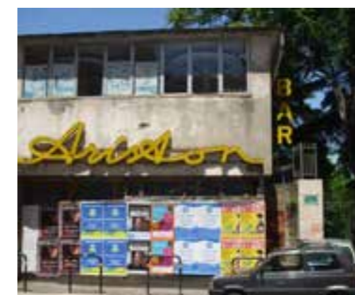
Figura 3: Vista del prospetto principale da via IV Novembre
