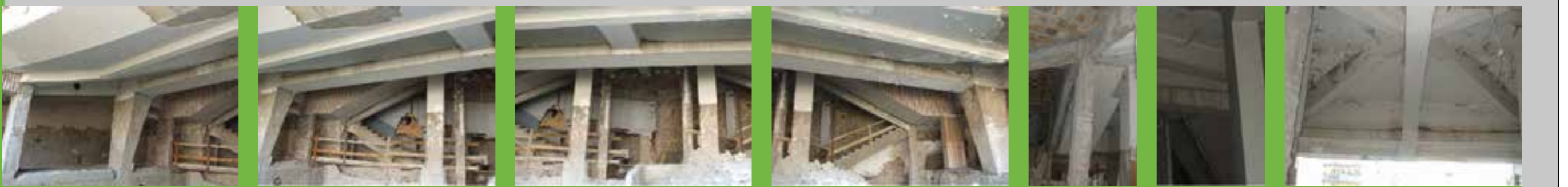
viste interne struttura
