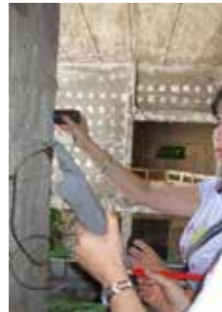
Figura 12: Esecuzione delle scansioni pacometriche
