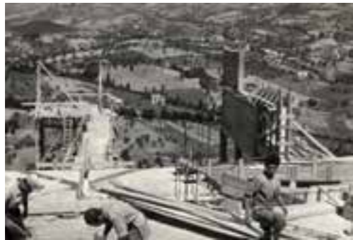
Figura 3: Immagine storica del cantiere
