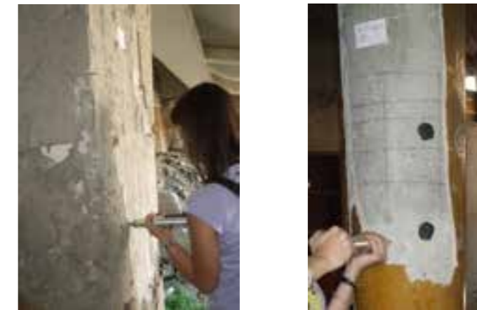
Figura 2: Esecuzione della prova sclerometrica
