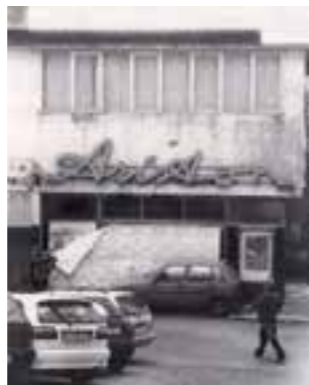
Figura 6: Stato attuale del Cinema Ariston da via IV Novembre
