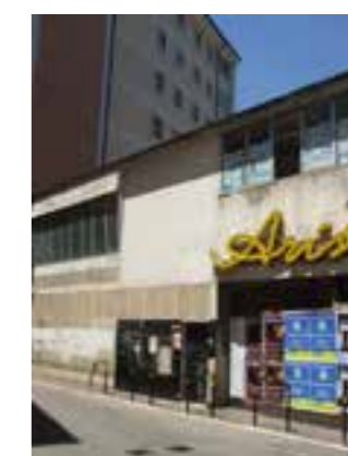
Figura 4: Vista del prospetto principale da via IV Novembre
