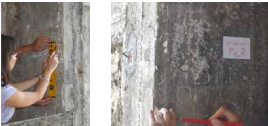
Figura 13: tracciamento del percorso delle armature sul calcestruzzo
