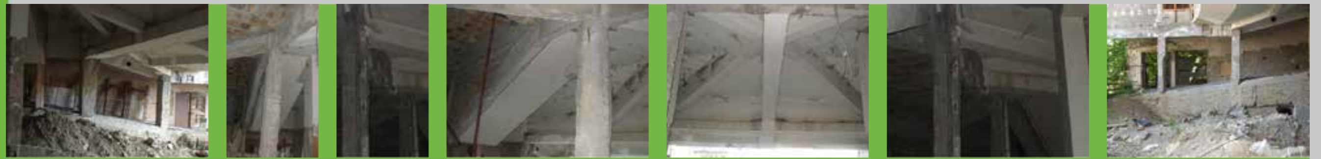
viste interne struttura
