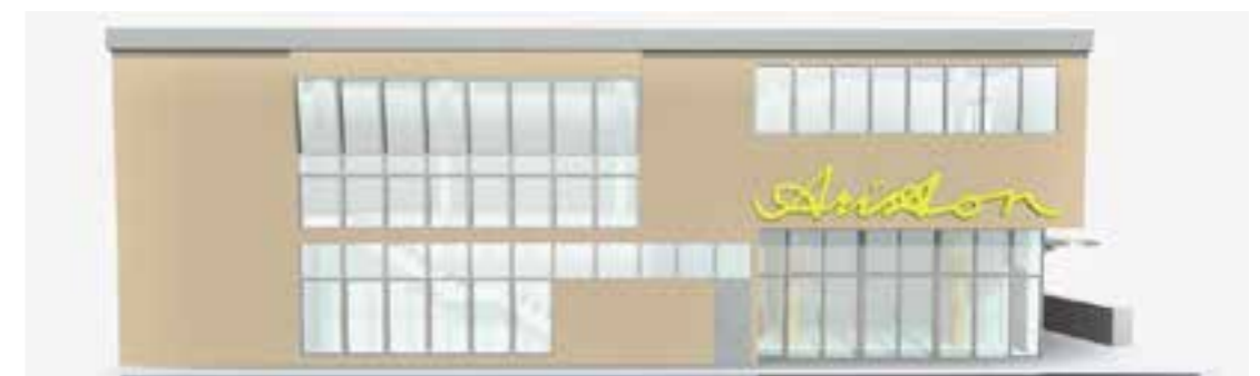
Figura 8: Vista prospettica dell'ingresso al Cinema da Via IV Novembre
