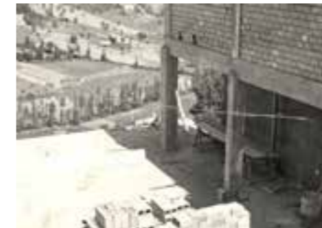
Figura 10: Immagine storica del cantiere
