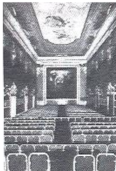
Figura 12: Vista della sala di proiezione del Cinema Moderno di Roma
