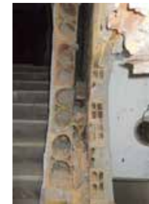
Figura 9: Immagine setto realizzato con gli occhialoni e mattoni forati
