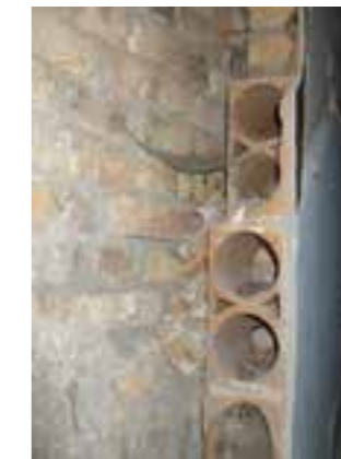
Figura 10: Immagine setto realizzato con gli occhialoni e mattoni pieni
