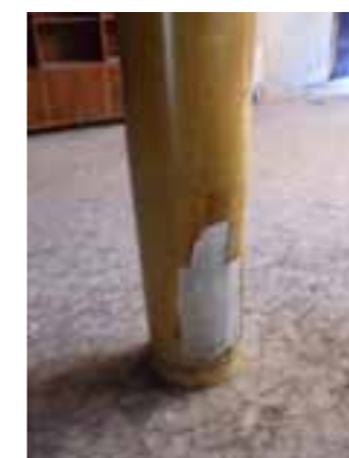
Figura 14: Immagine pavimentazione in marmo e pilastro con stucco a fuoco nell'atrio
