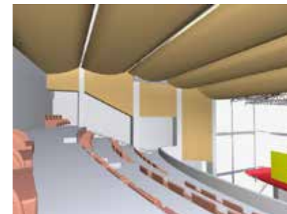
Figura 19: Vista interna della sala con pannelli acustici
