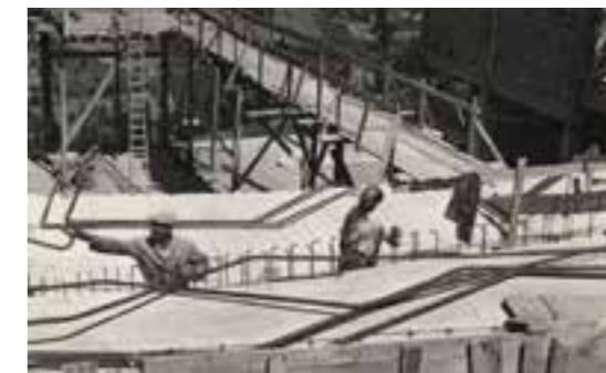
Figura 8: Immagine storica del cantiere
