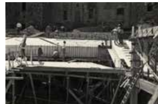
Figura 7: Immagine storica del cantiere
