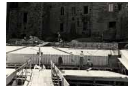
Figura 1: Immagine storica del cantiere
