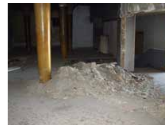
Figura 15: Immagine pavimentazione in marmo e pilastro con stucco a fuoco nell'atrio
