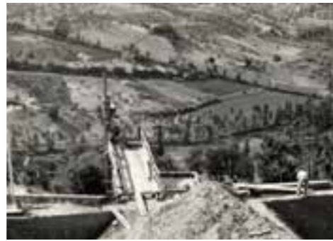
Figura 4: Immagine storica del cantiere
