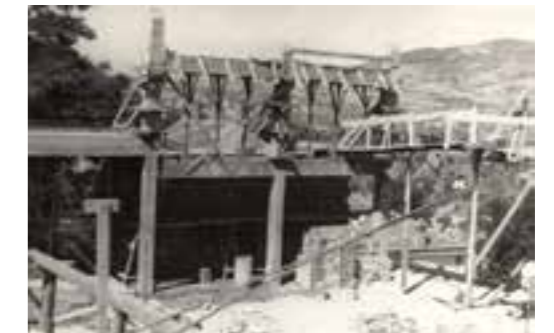
Figura 11: Immagine storica del cantiere
