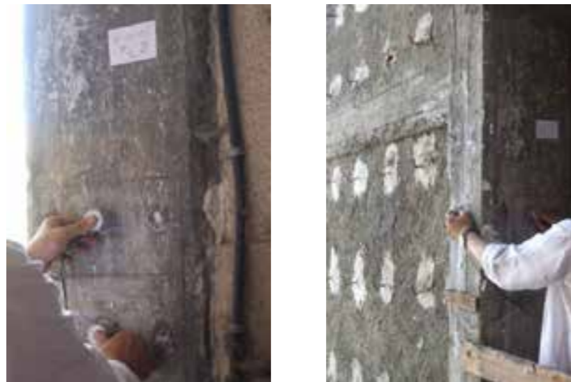
Figura 3: Esecuzione della prova ultrasonica
