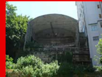
vista da via Mazzini
