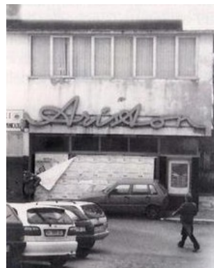
Figura 6: Stato attuale del Cinema Ariston da via IV Novembre
