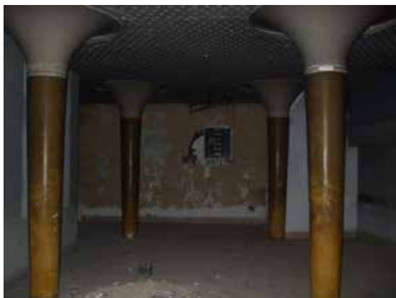
Figura 16: Immagine dei pilastri con stucco a fuoco nell'atrio
