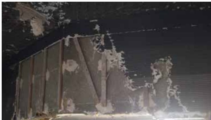
Figura 12: Immagine pannello acustico in gesso con ossatura lignea presente nell'atrio
