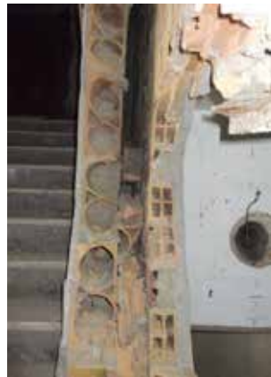
Figura 9: Immagine setto realizzato con gli occhialoni e mattoni forati
