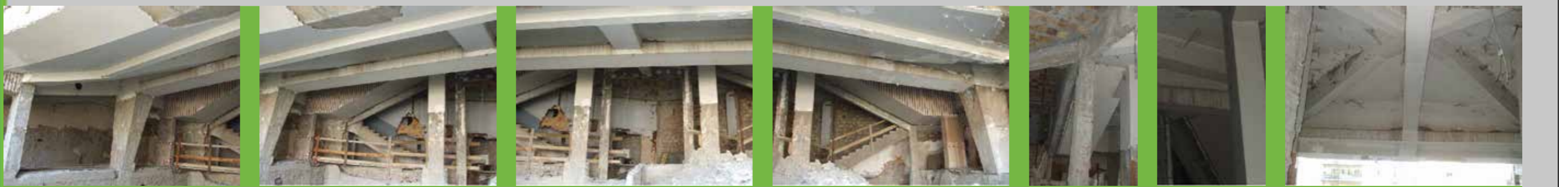
viste interne struttura
