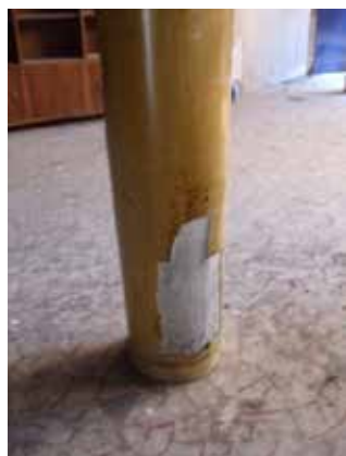
Figura 14: Immagine pavimentazione in marmo e pilastro con stucco a fuoco nell'atrio
