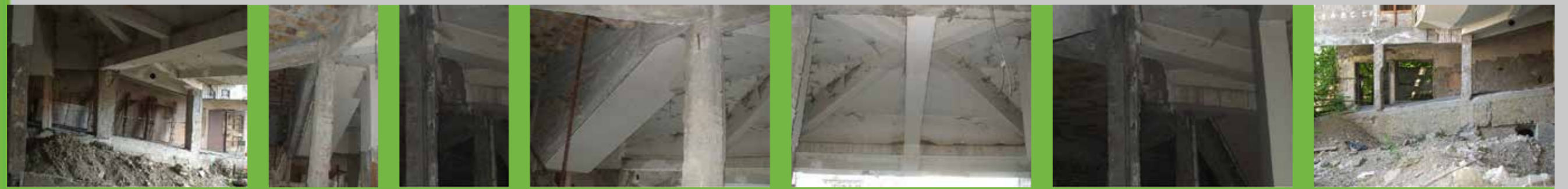
viste interne struttura
