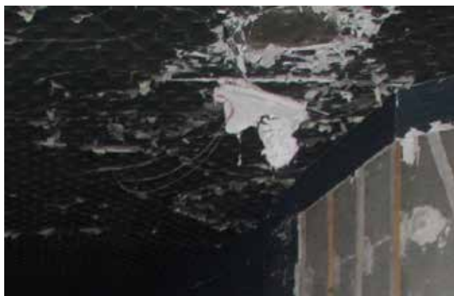
Figura 13: Immagine controsoffittatura in gomma presente nell'atrio
