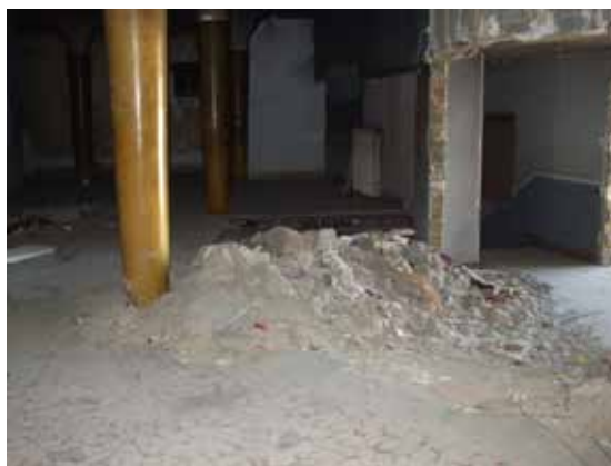
Figura 15: Immagine pavimentazione in marmo e pilastro con stucco a fuoco nell'atrio
