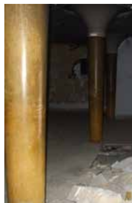
Figura 17: Immagine dei pilastri con stucco a fuoco nell'atrio
