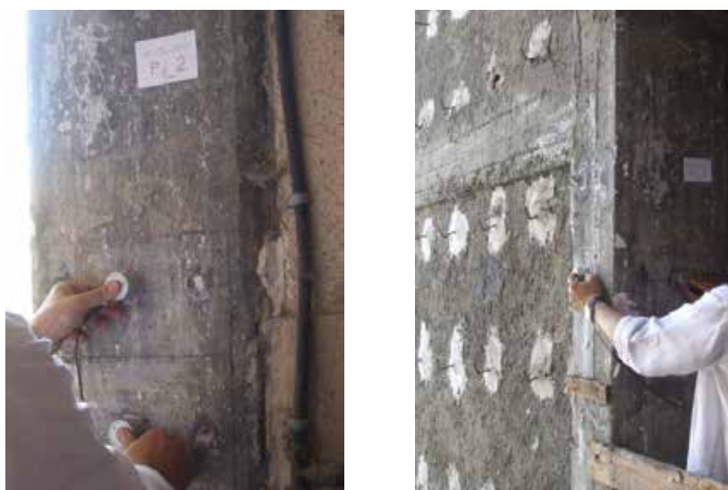
Figura 3: Esecuzione della prova ultrasonica
