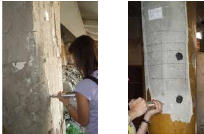
Figura 2: Esecuzione della prova sclerometrica
