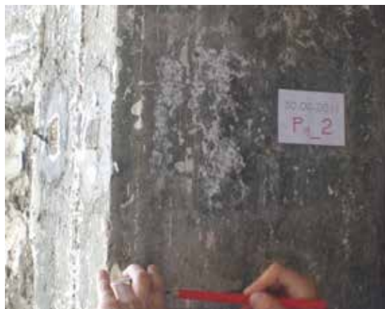
Figura 13: tracciamento del percorso delle armature sul calcestruzzo
