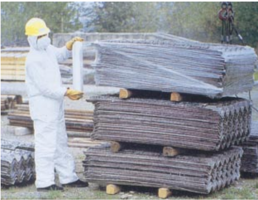
Confezionamento di lastre in cemento amianto da avviare a smaltimento finale
