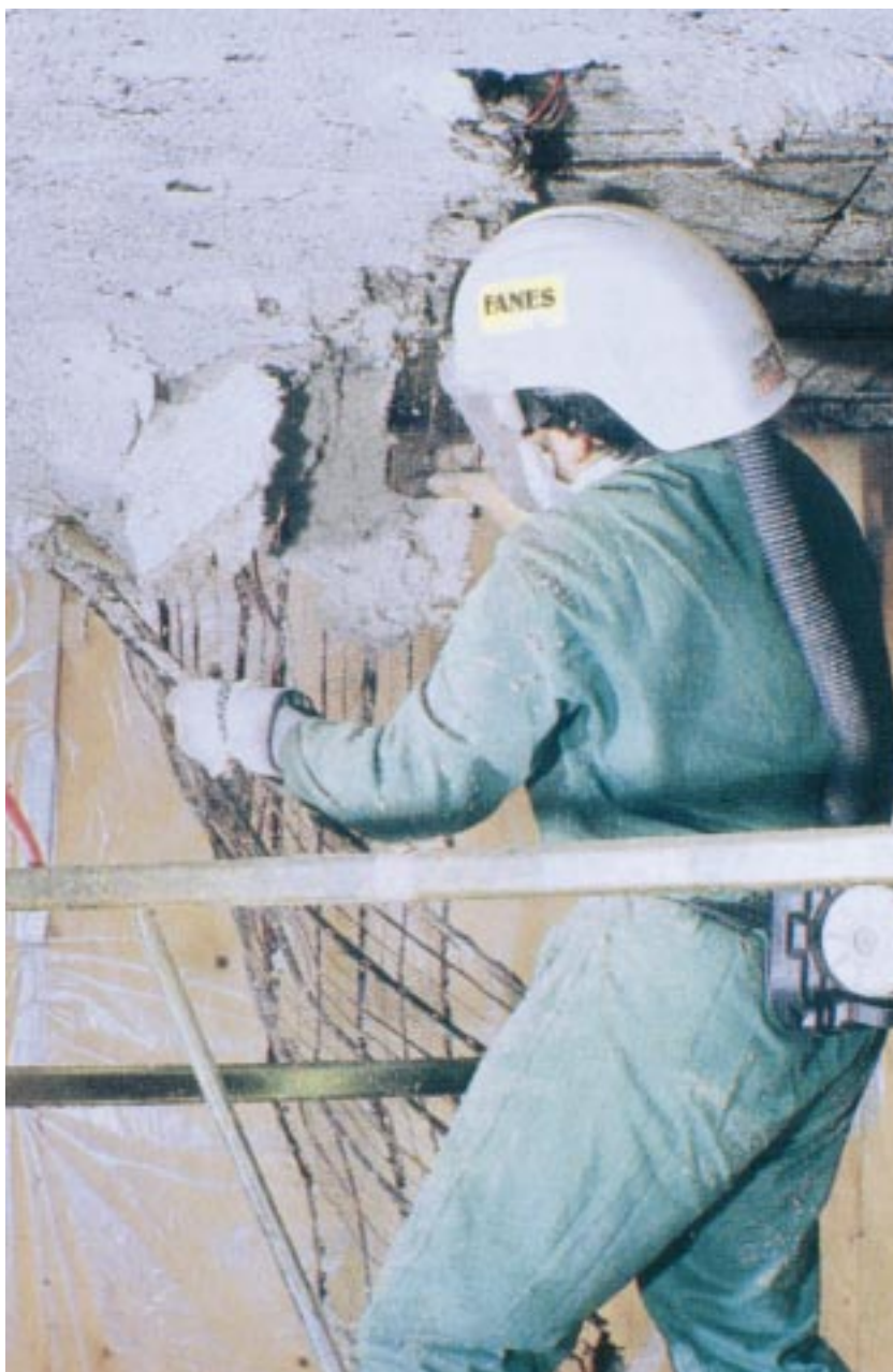
Rimozione di intonaco isolante con amianto floccato rinforzato
