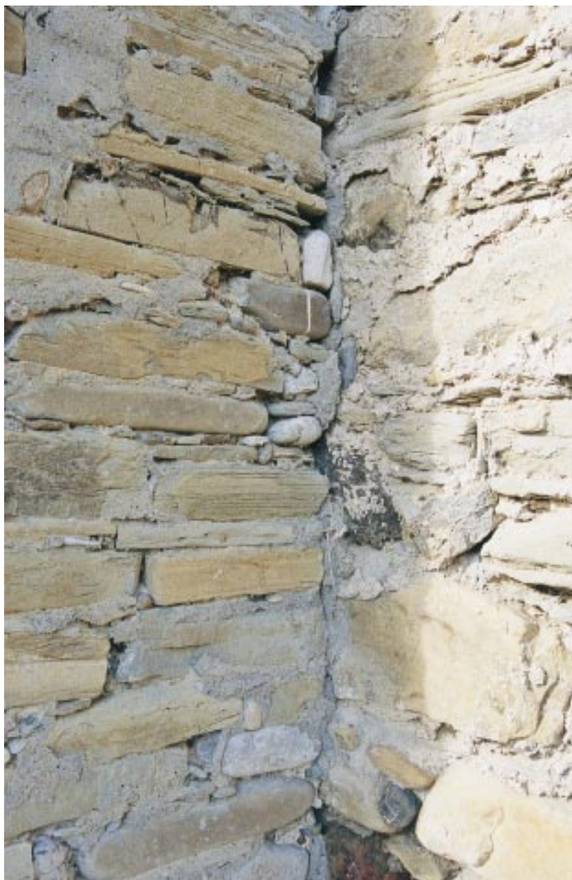
Particolare di un pilastro appoggiato sul prospetto meridionale (foto Lorusso-Rescio)
