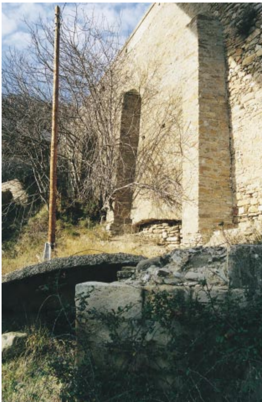
Resti di intonaco e fori per travicelli (foto Lorusso-Rescio)
