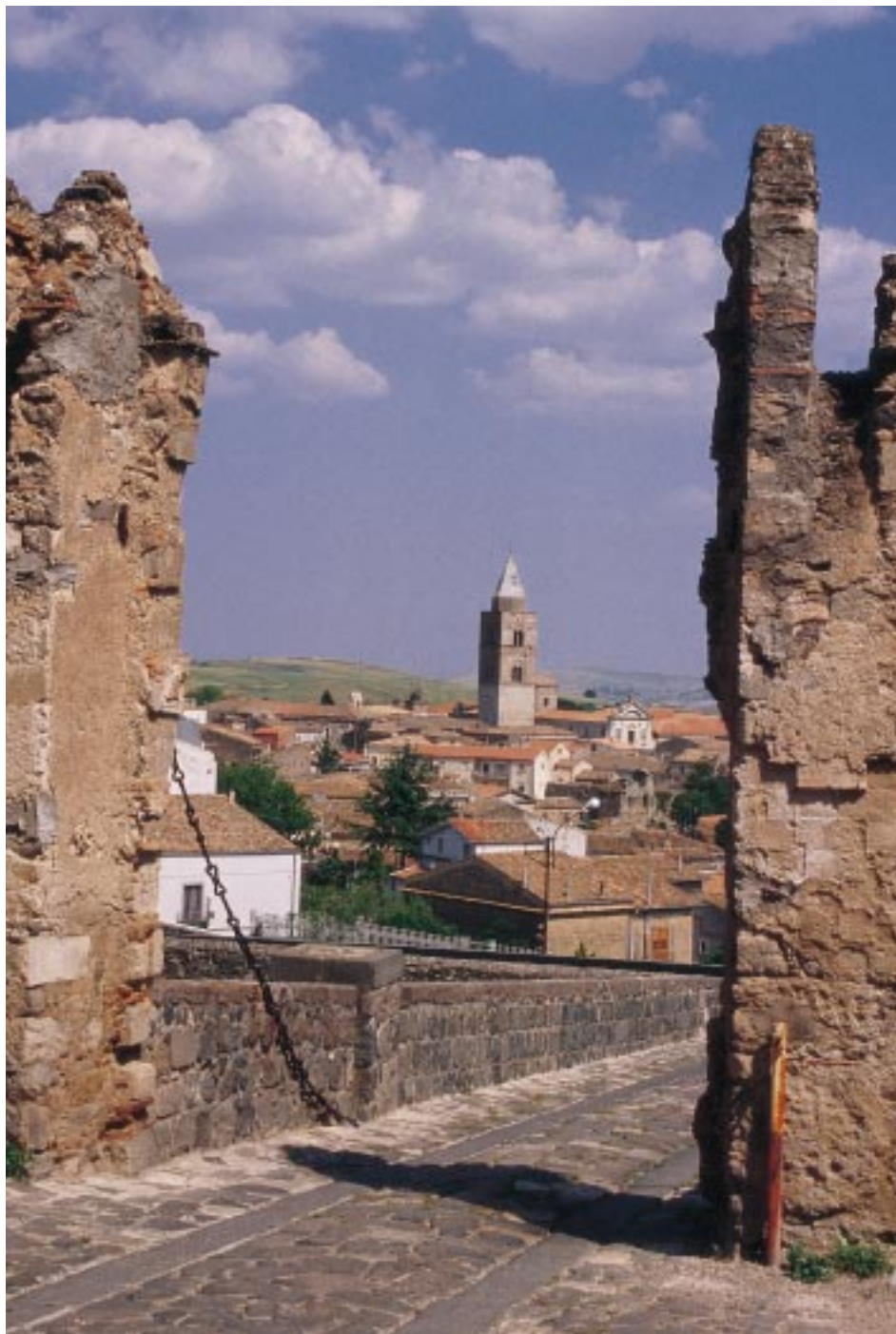
Melfi (PZ). Veduta del centro normanno con la Cattedrale dal castello (Foto: O. Chiaradia)
