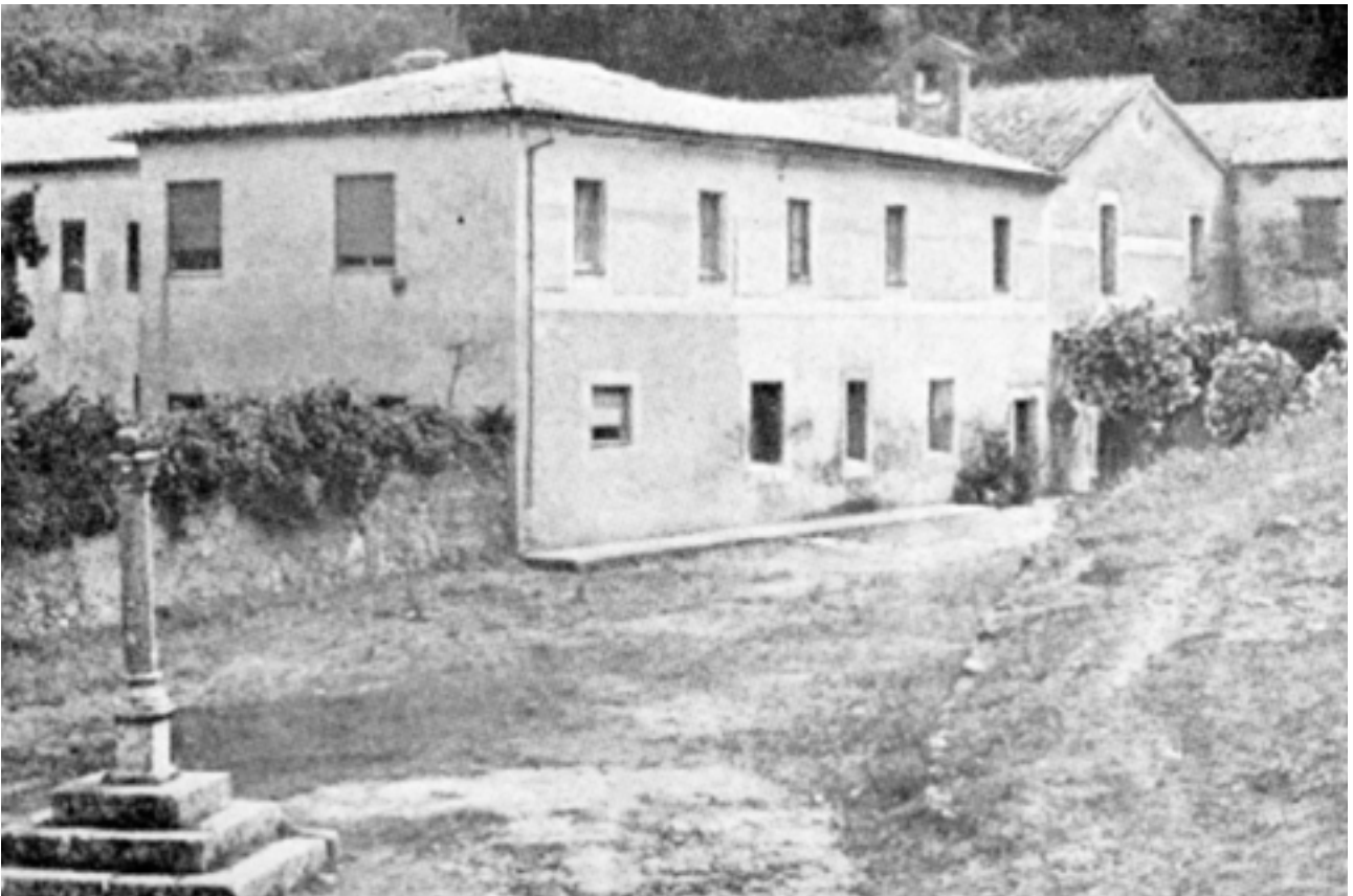
La chiesa ed il convento dei Cappuccini prima dei restauri.
