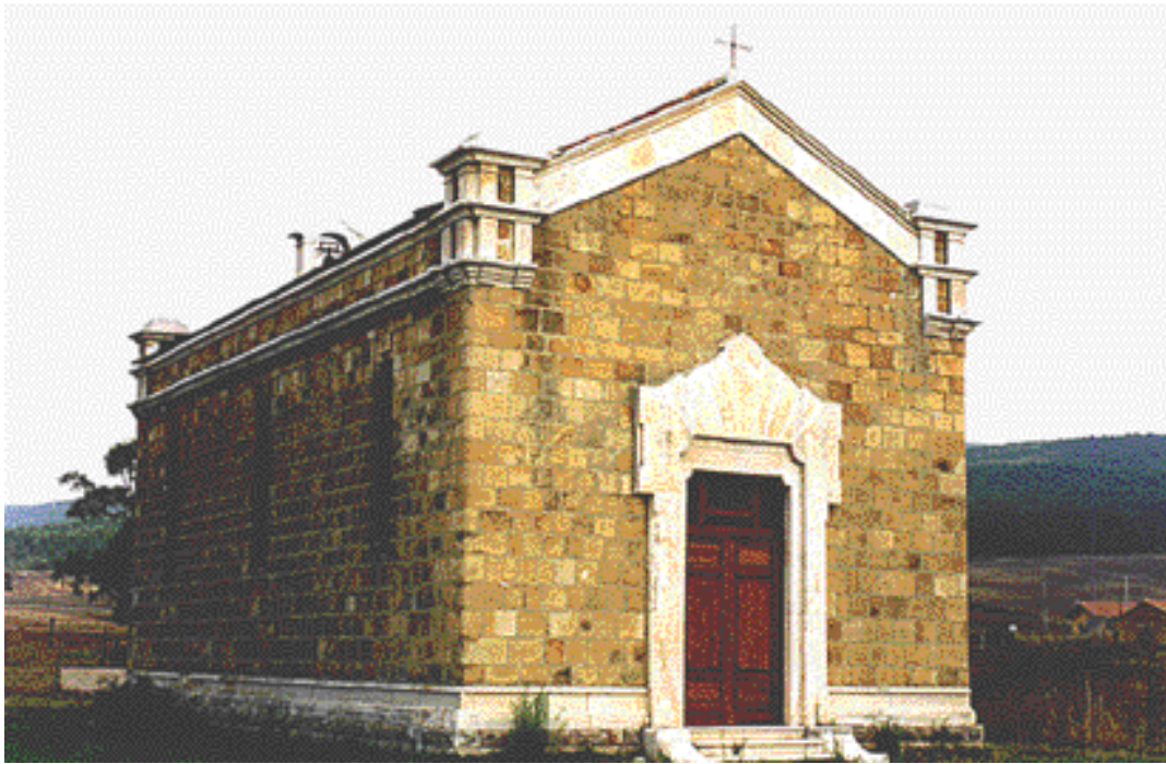
La chiesa, dedicata a S. Filippo Neri, si distingue dagli altri edifici per la maggiore ricchezza degli elementi decorativi realizzati in pietra calcarea bianca che emergono dal sobrio paramento in conci di pietra arenaria. I cordoli alla gronda e sui timpani coronano l'edificio definito alla sommità da quattro torrini sui cantonali e dall'edicola campanaria sul retro.
