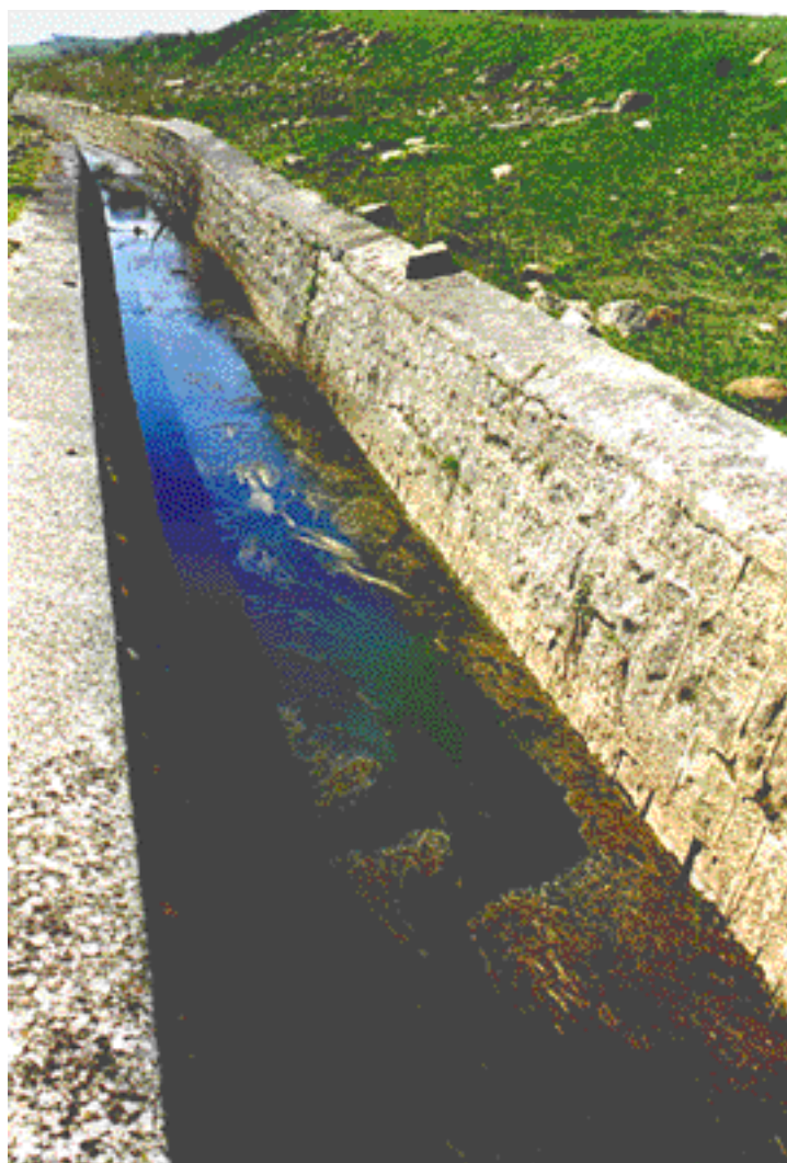
Il canale di scarico convoglia le acque nel Bradanello e, nella zona dei Carpini, presenta difese spondali in muratura.
