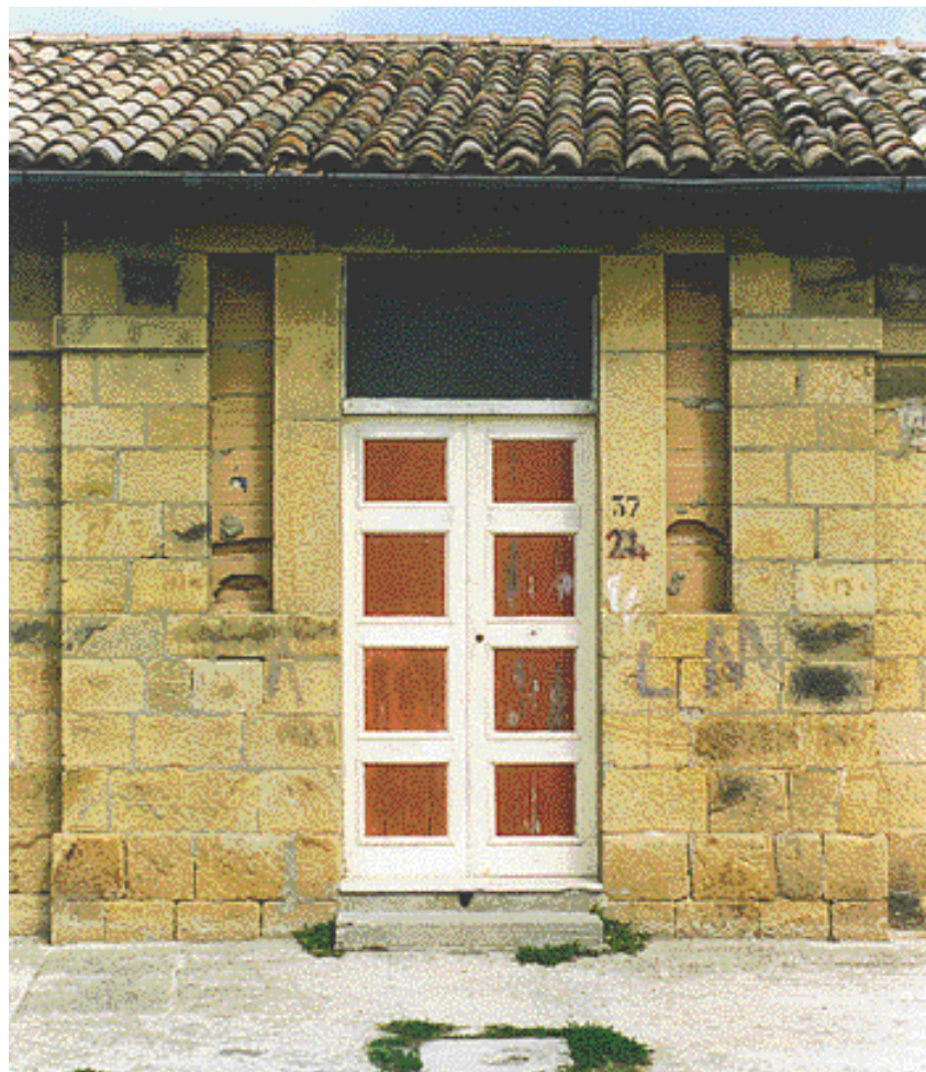
Particolare di facciata di uno degli edifici destinati a magazzino. Un lieve risalto planimetrico evidenzia l'ingresso, fiancheggiato da due strette monofore ora impropriamente tompagnate. L'ampio sporto del tetto è sorretto dai tipici gattelli lignei modanati.
