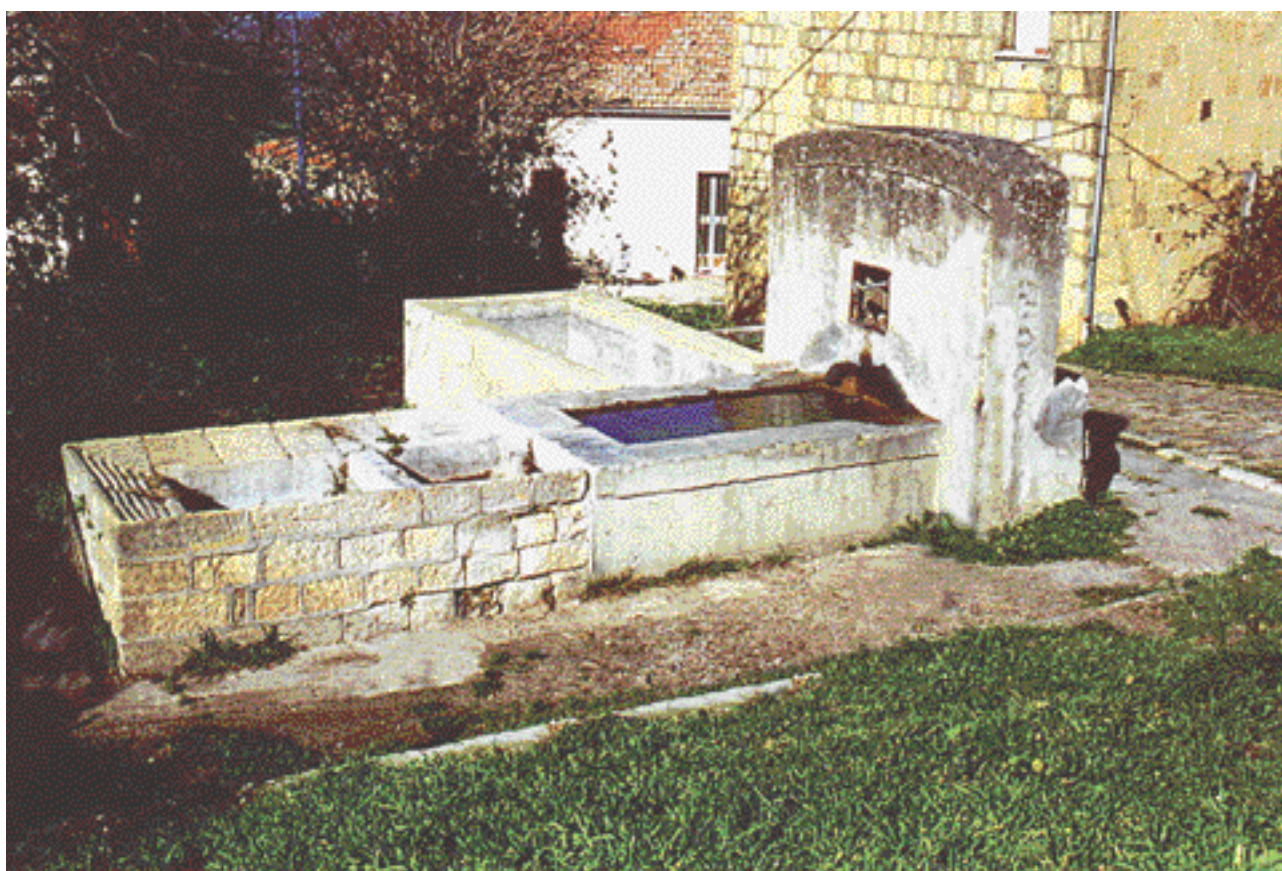
La fontana del borgo di Montalto costituita da più vasche degradanti per i diversi utilizzi idrici.
