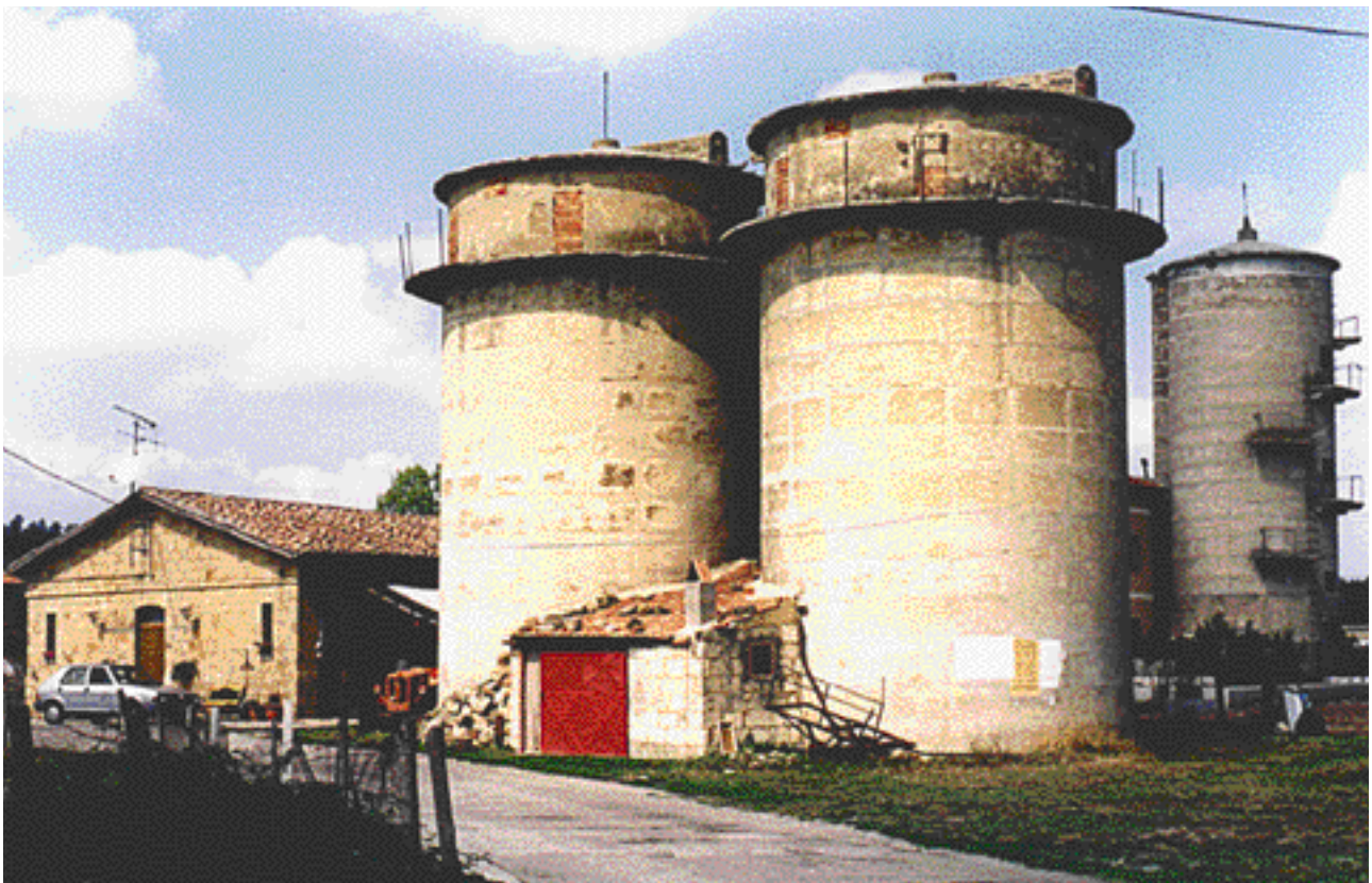
I grandi silos del centro azienda destinati alla conservazione del foraggio fresco per l'alimentazione dei bovini da latte. I primi due possono contenere 1000 quintali di foraggio e hanno un unico ballatoio anulare in sommità, mentre quello retrostante è più grande e raggiunge l'altezza di 14,50 metri. Nella foto a sinistra è inquadrata la vaccareccia, la grande stalla razionale per i bovini.
