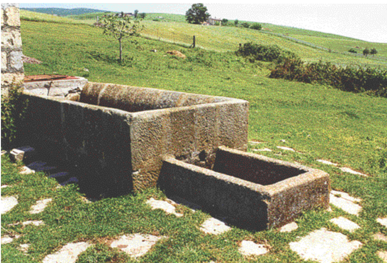
L'abbeveratoio della masseria Lago del Monaco con la vasca in pietra lavorata ed il sottostante catino per gli animali di piccola taglia.
