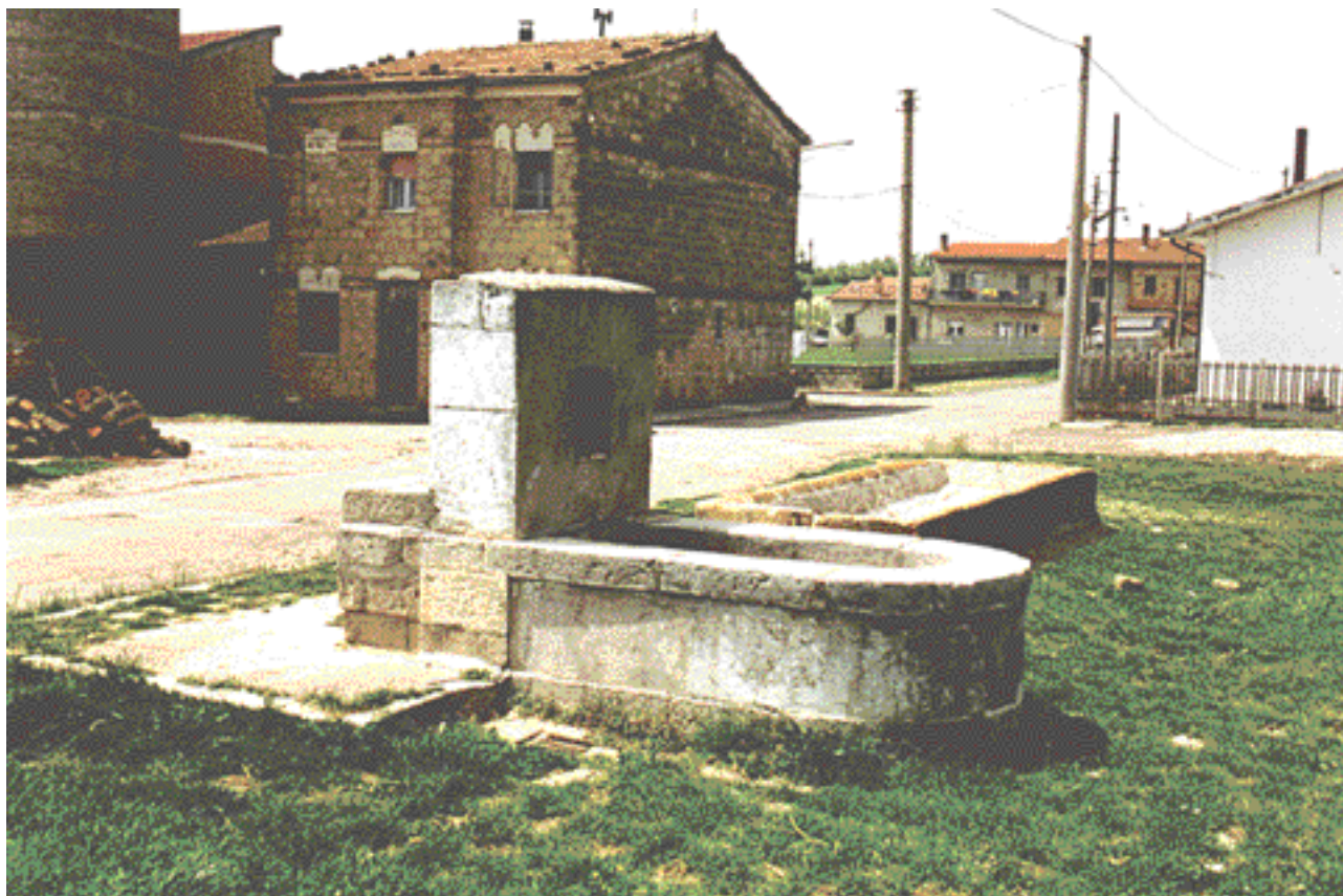
La fontana del centro azienda presenta il getto potabile lungo la strada, la vasca lavatoio nella parte retrostante e, lateralmente, l'abbeveratoio e la cisterna interrata.
