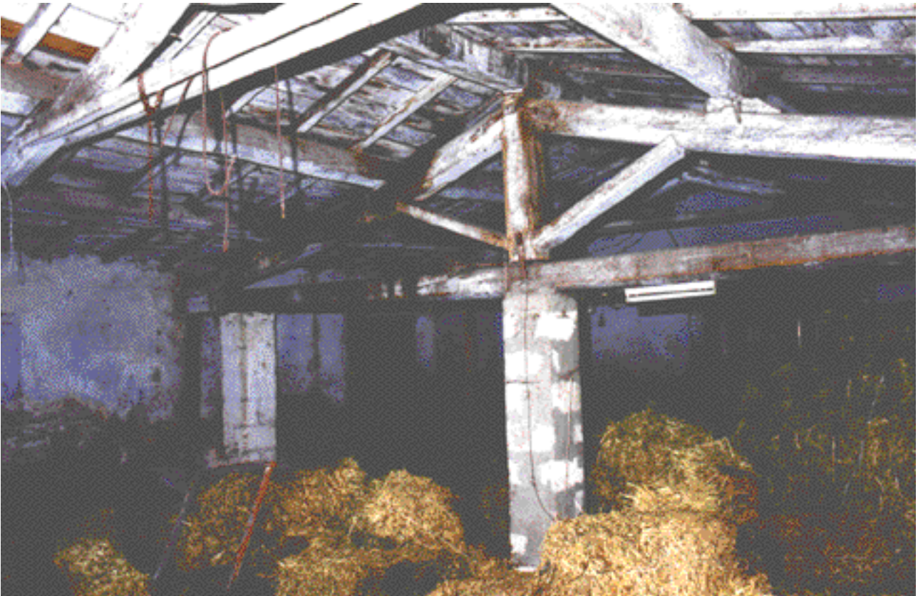
L'interno della stalla della masseria Chicone , ora adibita a fienile, che conserva l'impianto tipologico "groppa a groppa" e molti degli elementi originari: le greppie lungo le pareti laterali, le incavallature lignee della copertura, i basolati delle pavimentazioni e i canali di scolo che convogliavano i liquami nella concimaia.
