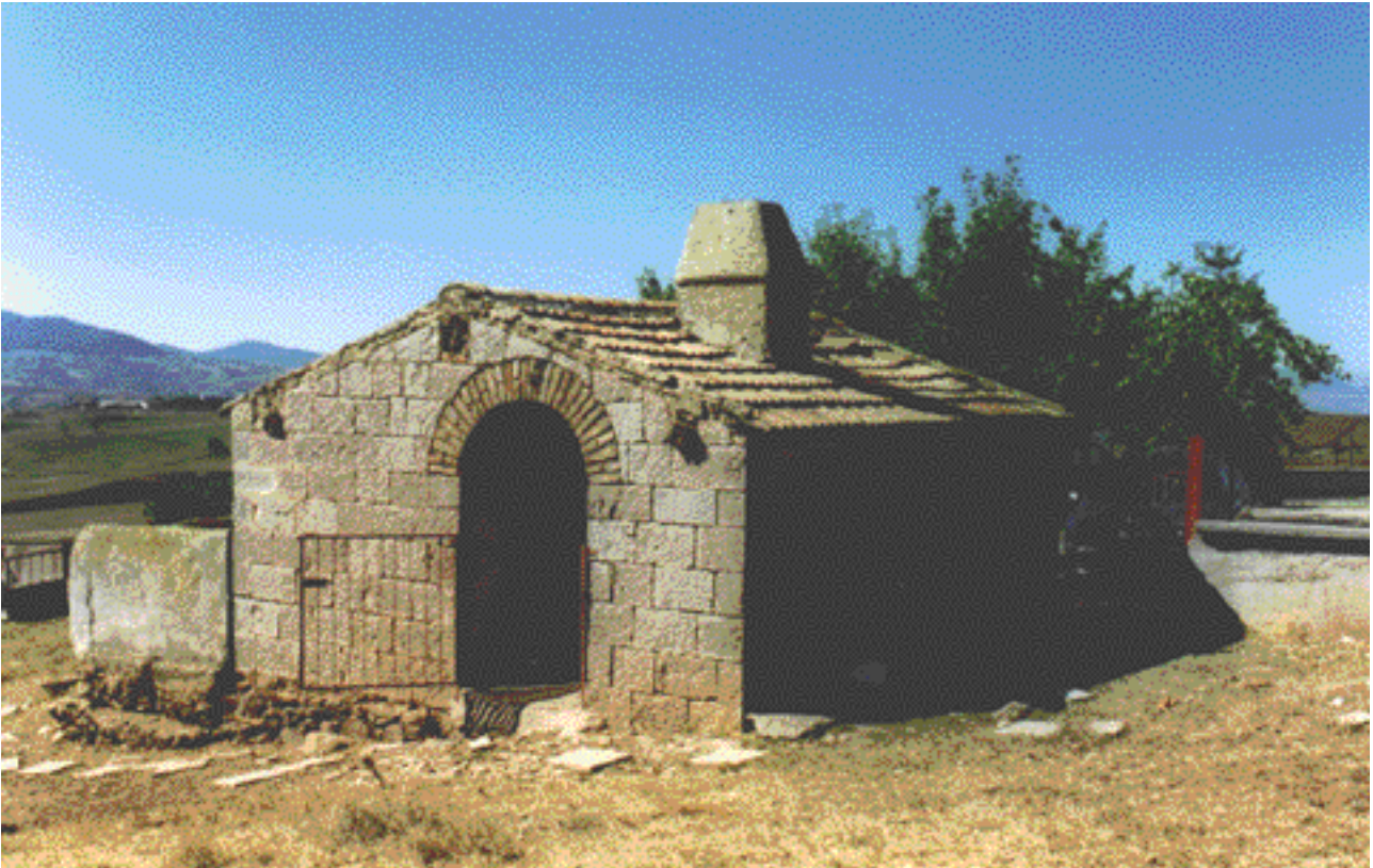
Il forno, solitamente ubicato sotto il portico, è, nella masseria Serra dell'Olmo 2ª , edificato a parte. Il singolare fabbricato, in pietra a vista, è costituito da una camera a cupola coperta a due falde, piccola anticamera per la bocca con superiore cappa e accesso archivoltato in mattoni.
