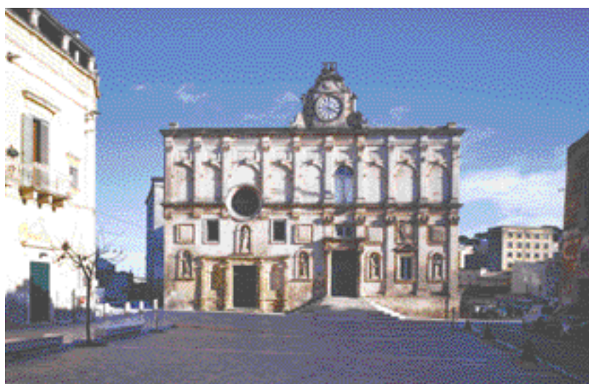
Matera. Palazzo Lanfranchi. Prospetto principale.
