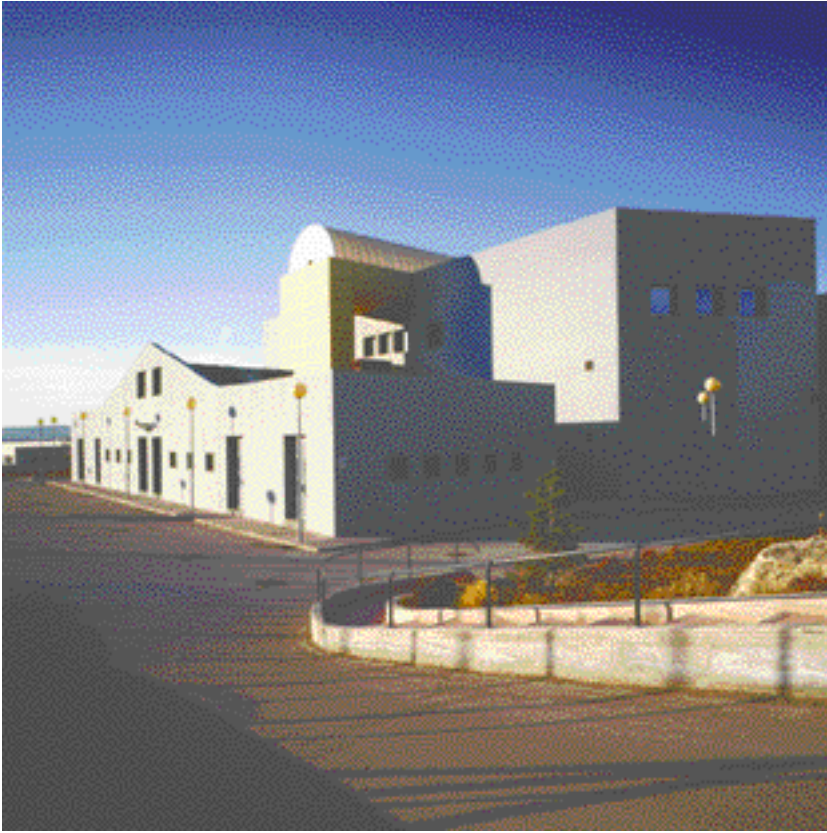
Laboratorio di Restauro, esterno.
