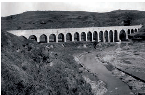
Ponte canale fiumara di Atella
