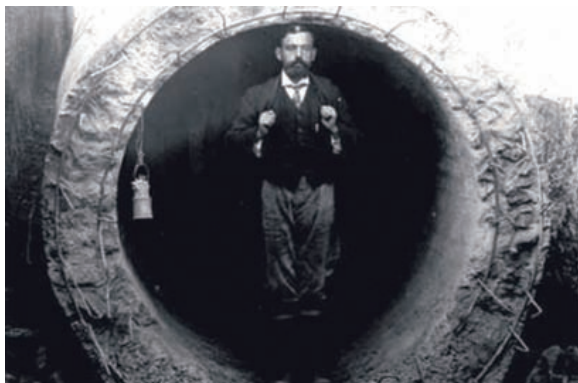
dimensione della condotta in cemento armato
