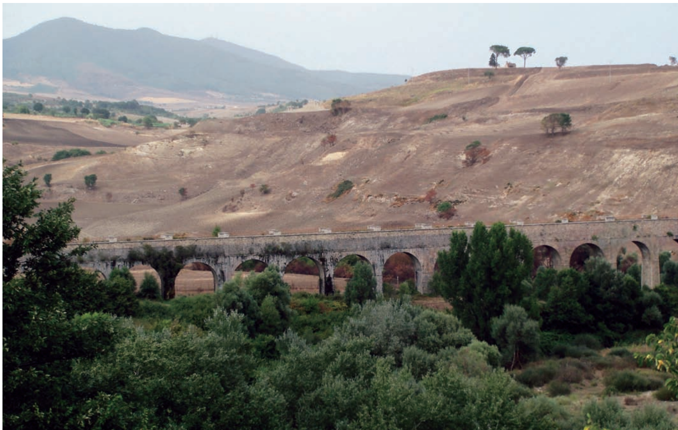
Ponte canale sulla fiumara di Atella
