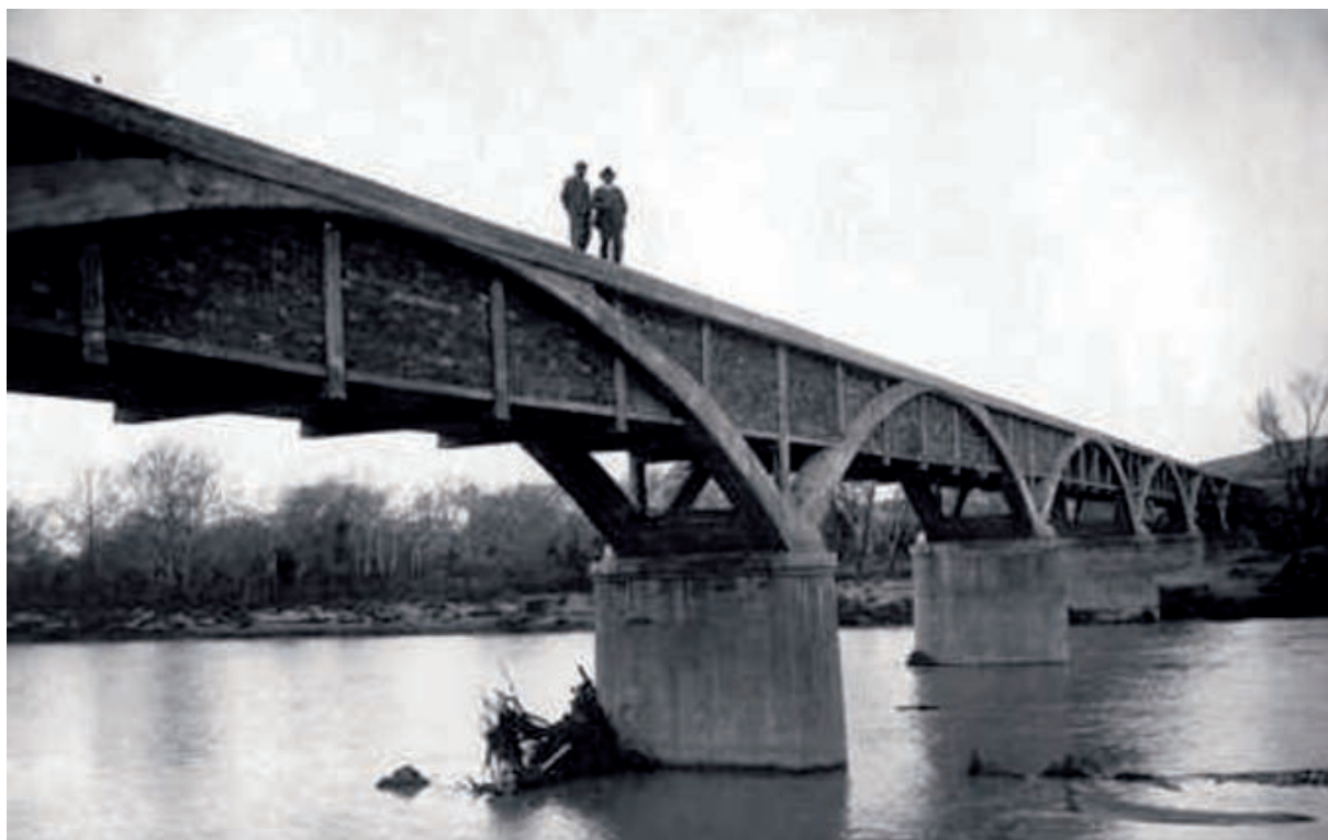
Ponte canale sul fiume Ofanto
