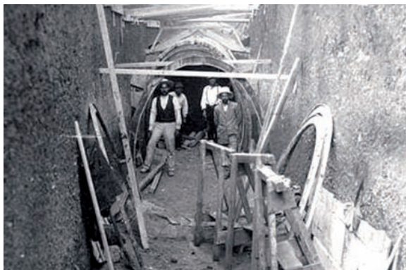
lavori in galleria
