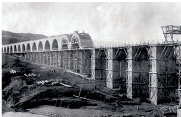
Fase costruttiva del ponte - acquedotto sulla fiumara di Atella
