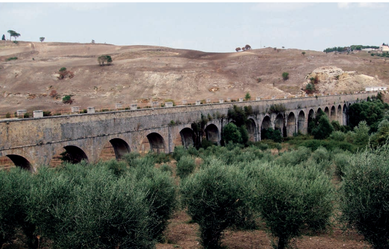
Ponte canale sulla fiumara di Atella
