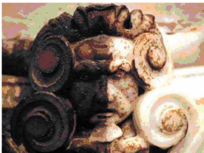
Figura 2. pulitura delle croste nere sul marmo del capitello nel 1997 con il composto AB57 e con metodi meccanici.
