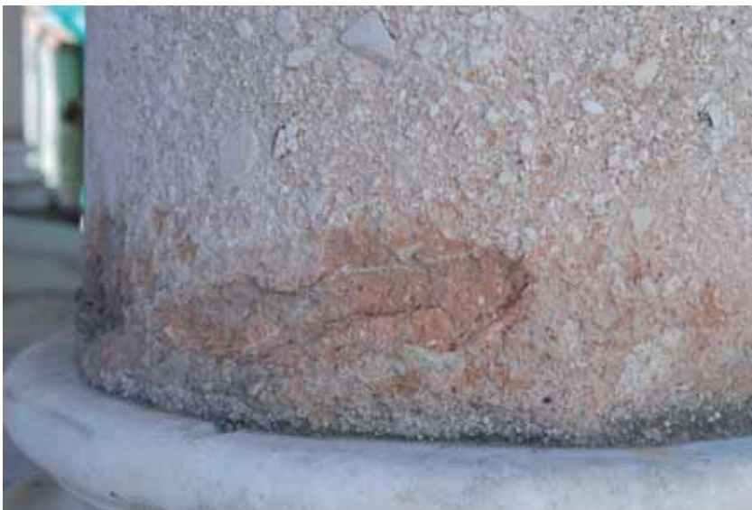
Figura 4. La macrofotografia della base della seconda colonna mostra la degradazione differenziale della breccia e la stuccatura del 1997. Ripresa fotografica effettuata in data 11 marzo 2008.
