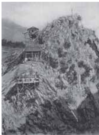
Fig 1. Castello del frantumatore, pontile di gettata. Archivio Centro Culturale Franco Italiano. Muro Lucano (PZ)
