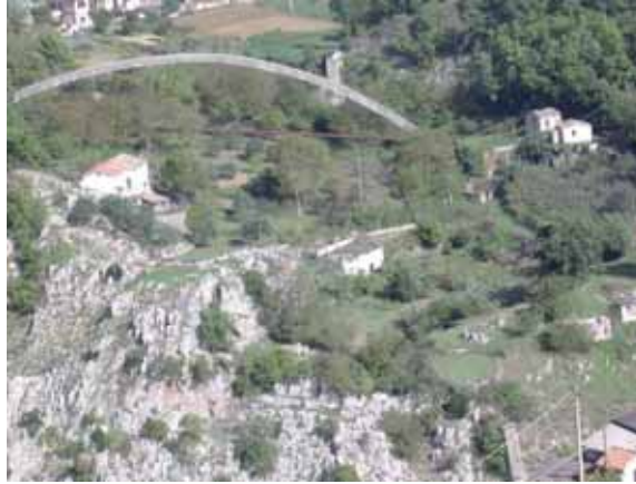
Fig. 6. Sono ancora visibili tracce dei muri delle vasche di ritenuta e approvvigionamento del sistema idrico dei mulini. (Archivio Privato A. Nardiello)
