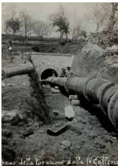
Fig. 13. Linea della condotta forzata a partire dall'ultima galleria.
