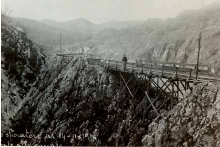
Fig. 10. Casseforme per il getto del coronamento impalcatura per getto dello sfioratore. ( Archivio Privato A. Nardiello )
