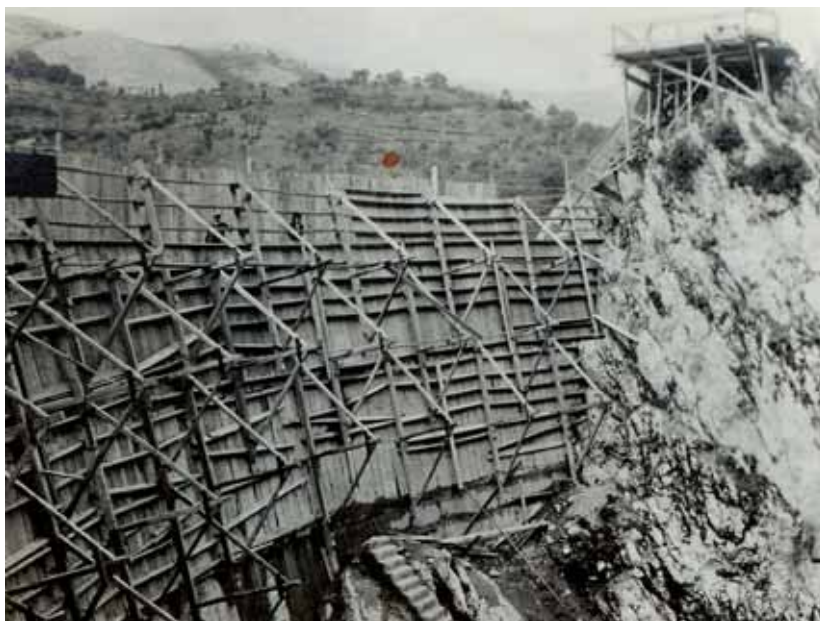
Fig. 8. Casseforme per il getto del corpo diga. ( Archivio Privato A. Nardiello )
