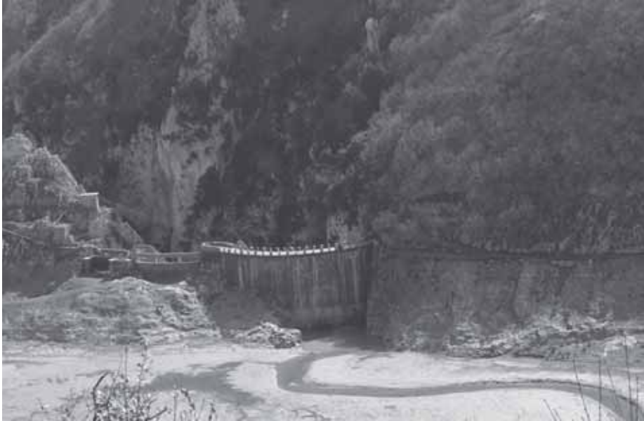
Fig.1. Massiccio calcareo in prossimità del corpo diga. (Archivio Privato A. Nardiello)
