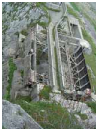
Fig. 5. Paratoia a contrappeso
