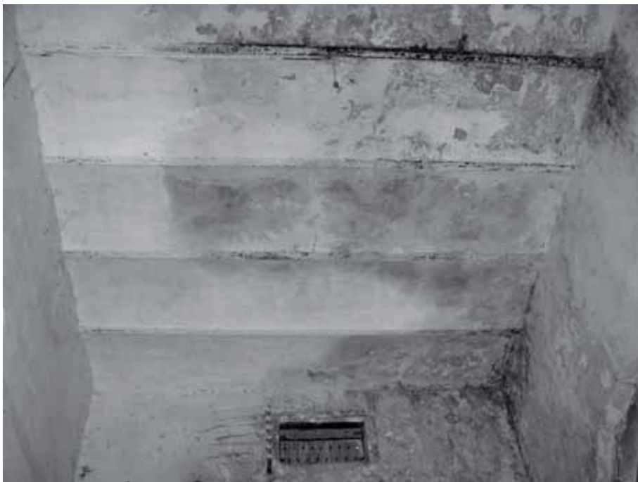
Fig. 9. Particolare della copertura a voltine del casotto adiacente alla centrale. (Archivio Privato A. Nardiello)
