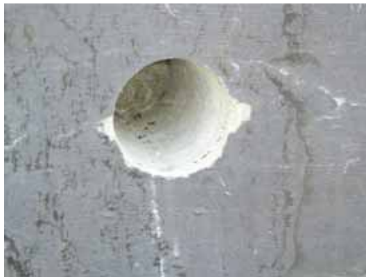
Fig. 14. Particolare del carotaggio nel paramento di monte.
