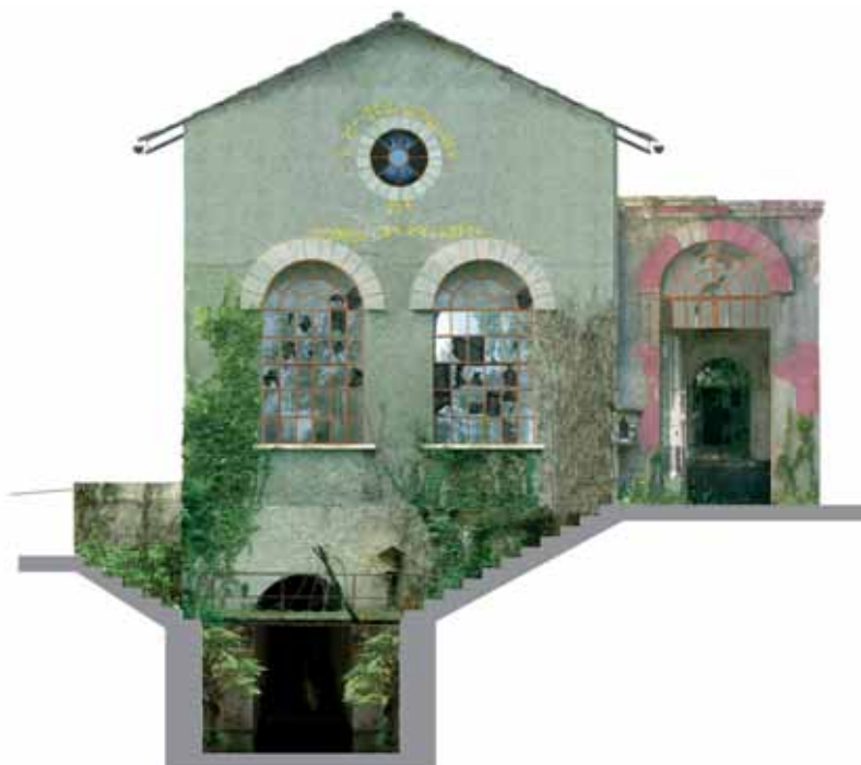
Fig. 1. Il prospetto SUD della centrale.
