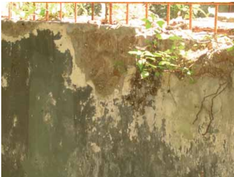
Fig. 6. Particolare dell'intonaco interno. ( Archivio Privato A. Nardiello ).
