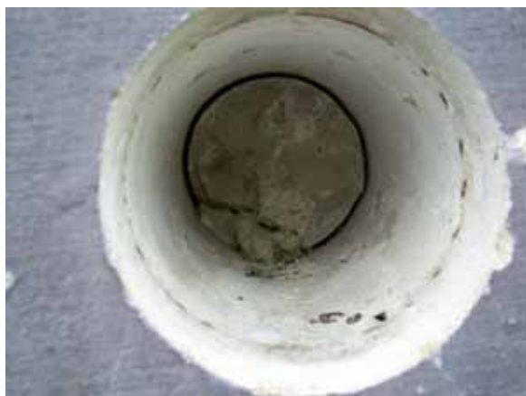
Fig. 13. particolare del carotaggio nel paramento di monte.
