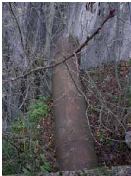
Fig. 15. Particolare delle condotte dell'opera di presa.
