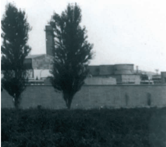
Stabilimenti industriali della Val Basento (foto archivio Consiglio regionale)
