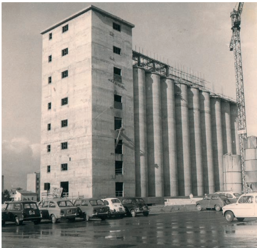
Il nuovo stabilimento dei Padula in via Cererie
