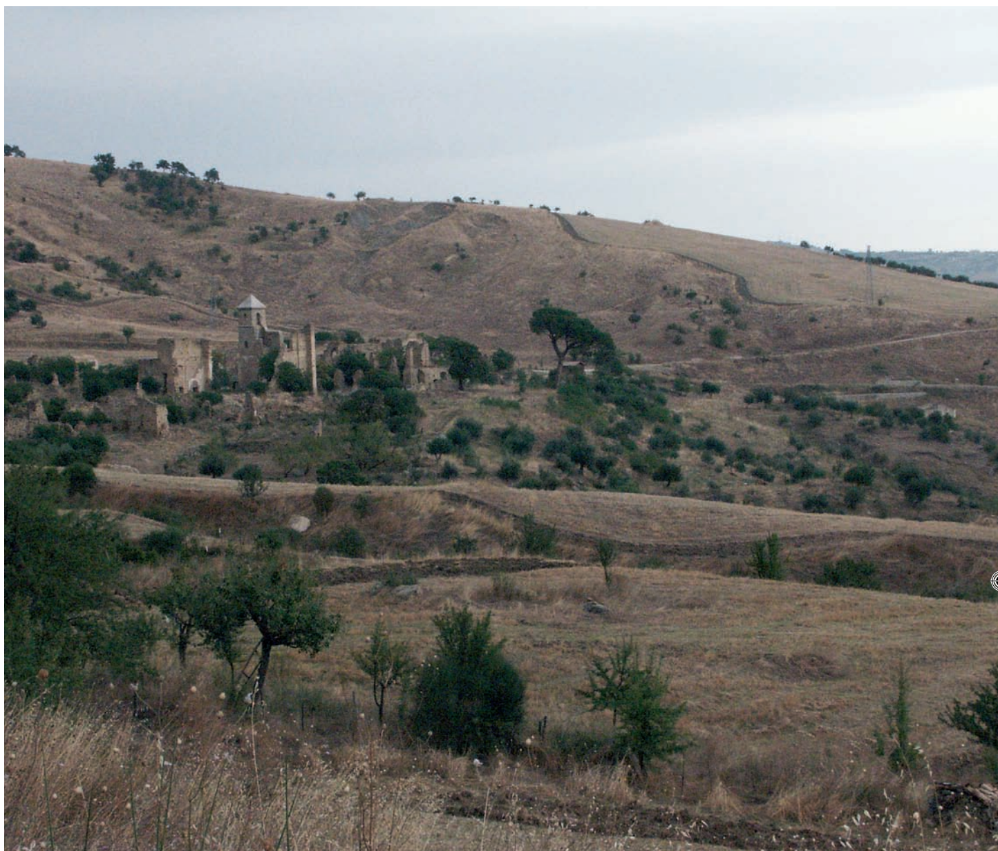
Figura 21 Corpo di frana sul quale il paese di Campomaggiore Vecchio conserva la sua integrità urbanistica. Sullo sfondo la conca di distacco della frana dove originariamente sorgeva il paese
