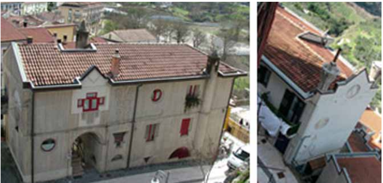
Figure 4.19-4.20 Viste degli edifici del Borgo nei pressi del Castello
