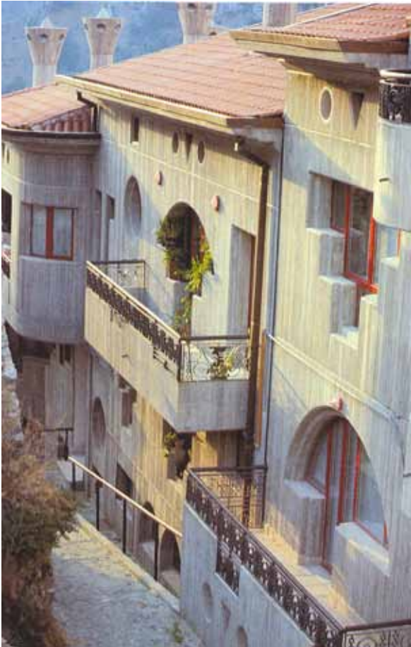
Figura 4.21 Vista degli edifici del Borgo nei pressi del Castello
