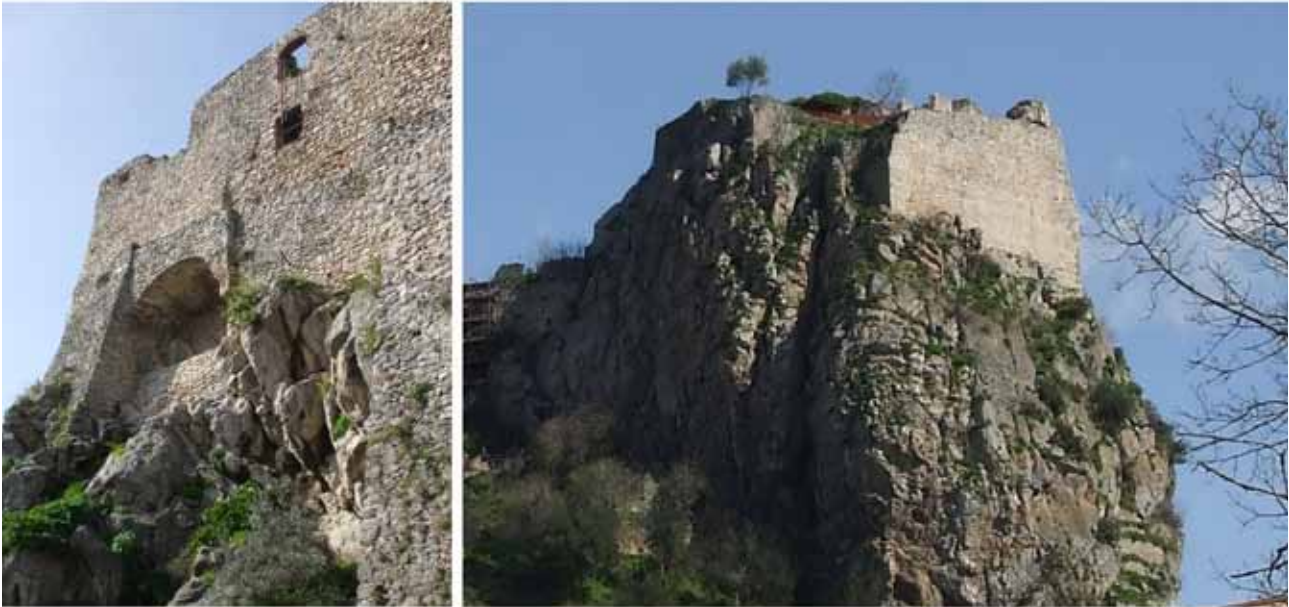
Figure 4.3-4.4 Viste dell'intersezione tra i paramenti murari del Castello con la rupe calcarea su cui sorge
