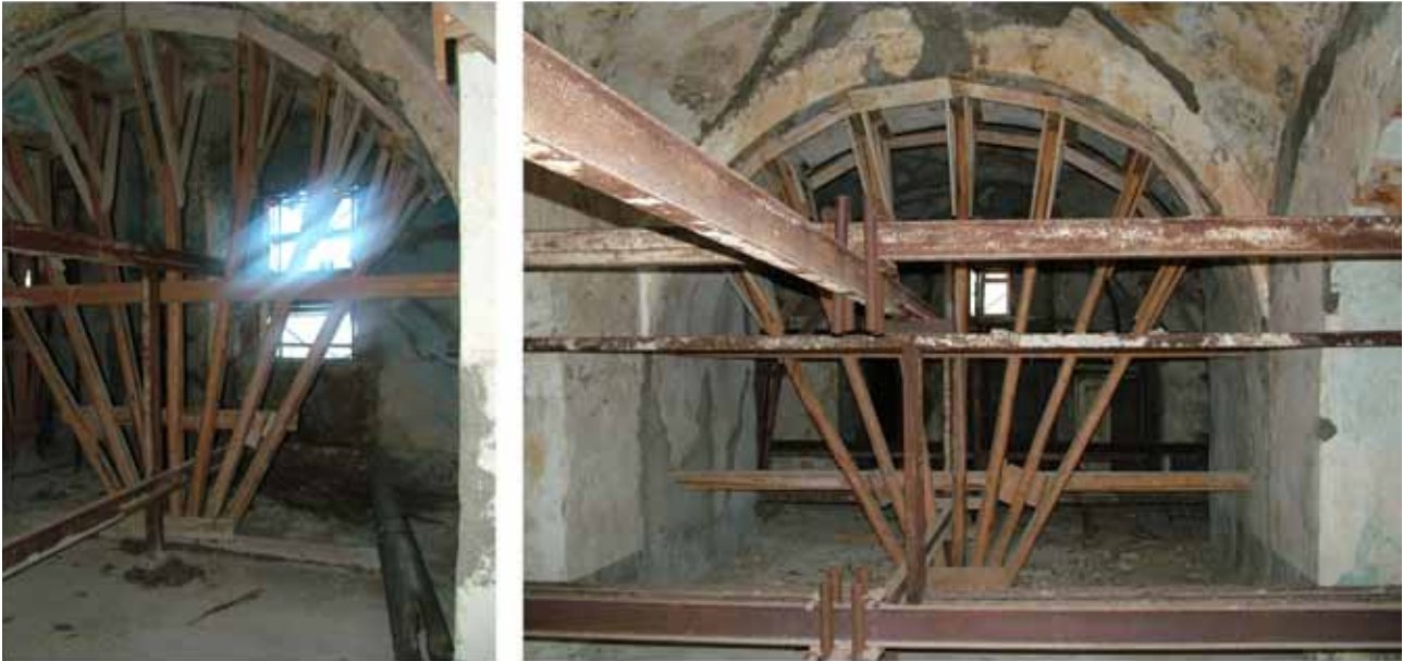
Figure 4.16-4.17 Viste interne del volume della Filanda con strutture puntellate e tirantate
