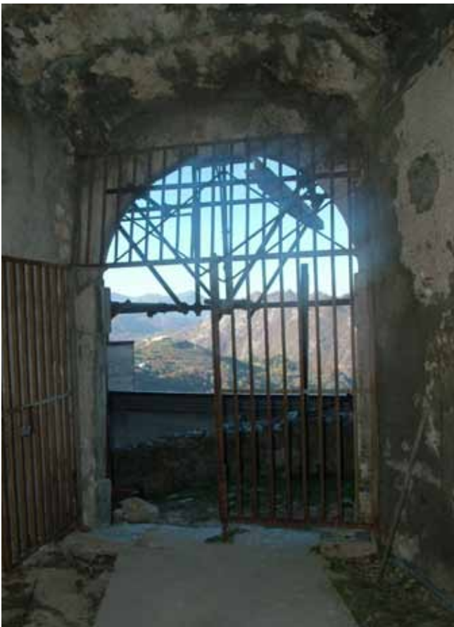
Figura 4.8 Vista dell'androne voltato di ingresso
