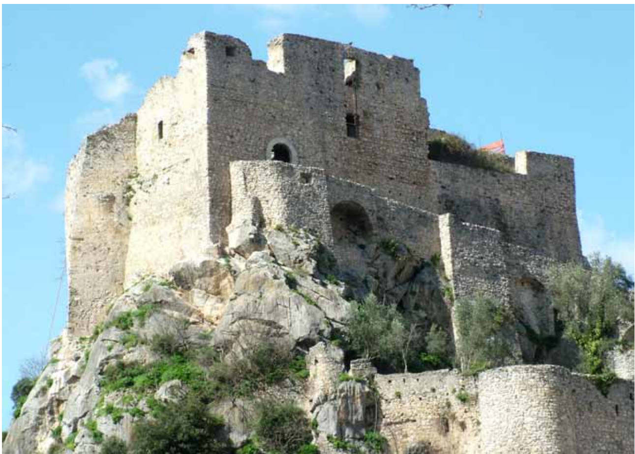
Figura 5.2 Vista del corpo più alto del Castello corrispondente al primitivo impianto
