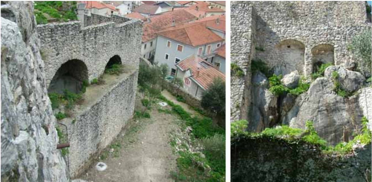
Figure 8.6-8.7 Strutture murarie del Castello per le quali si prevedono interventi di conservazione delle superfici lapidee
