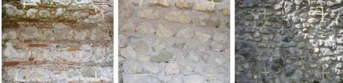
Figure 6.4-6.5-6.6 Tipologie murarie rilevate sui paramenti del Castello
