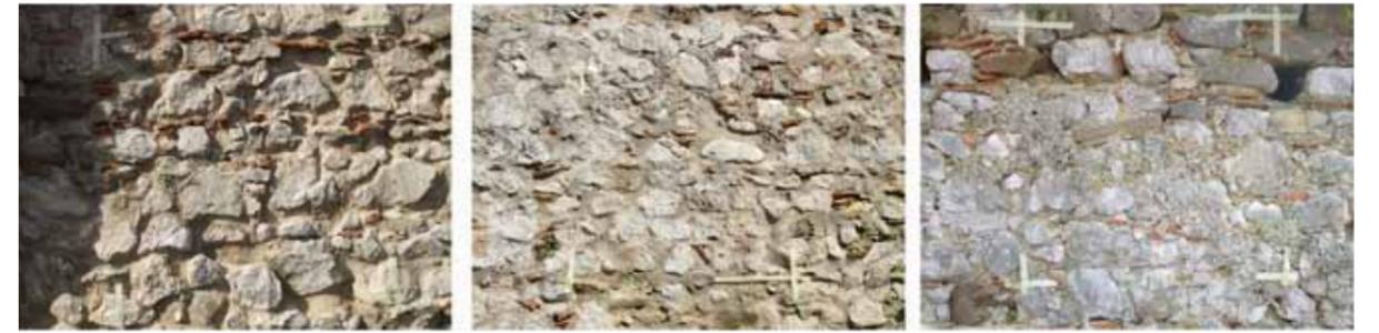
Figure 6.10-6.11-6.12 Tipologie murarie rilevate sui paramenti del Castello
