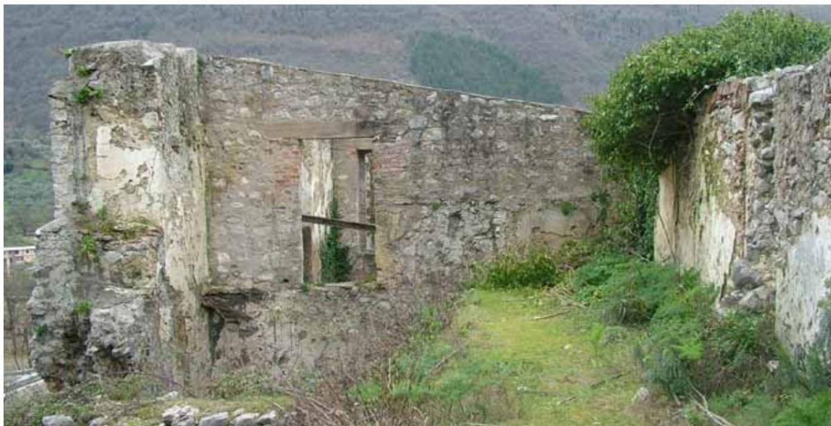
Figura 4.11 Vista del rudere con paramenti murari e orizzontamenti crollati
