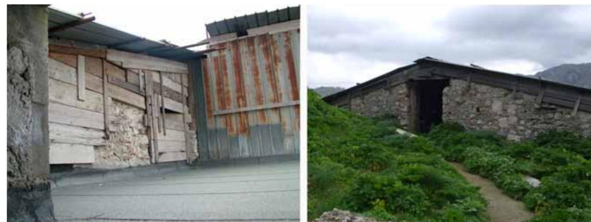
Figure 7.7-7.8 Copertura fatiscente del volume della Filanda
