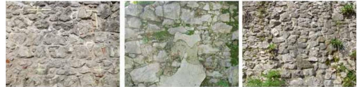
Figure 6.7-6.8-6.9 Tipologie murarie rilevate sui paramenti del Castello
