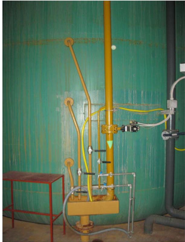
Figura 2.17: Serbatoi filtri a Carbone Attivo Granulare
