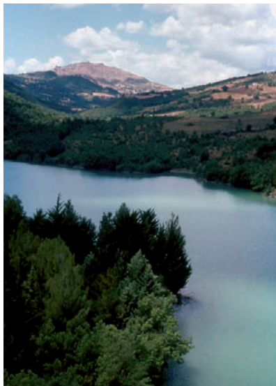
Diga della Camastra (foto di Arcangelo Palese)
