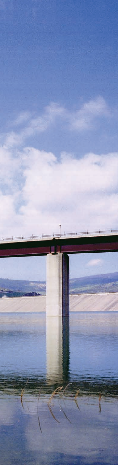
Diga di Monte Cotugno (foto di Massimo Boldrin)
