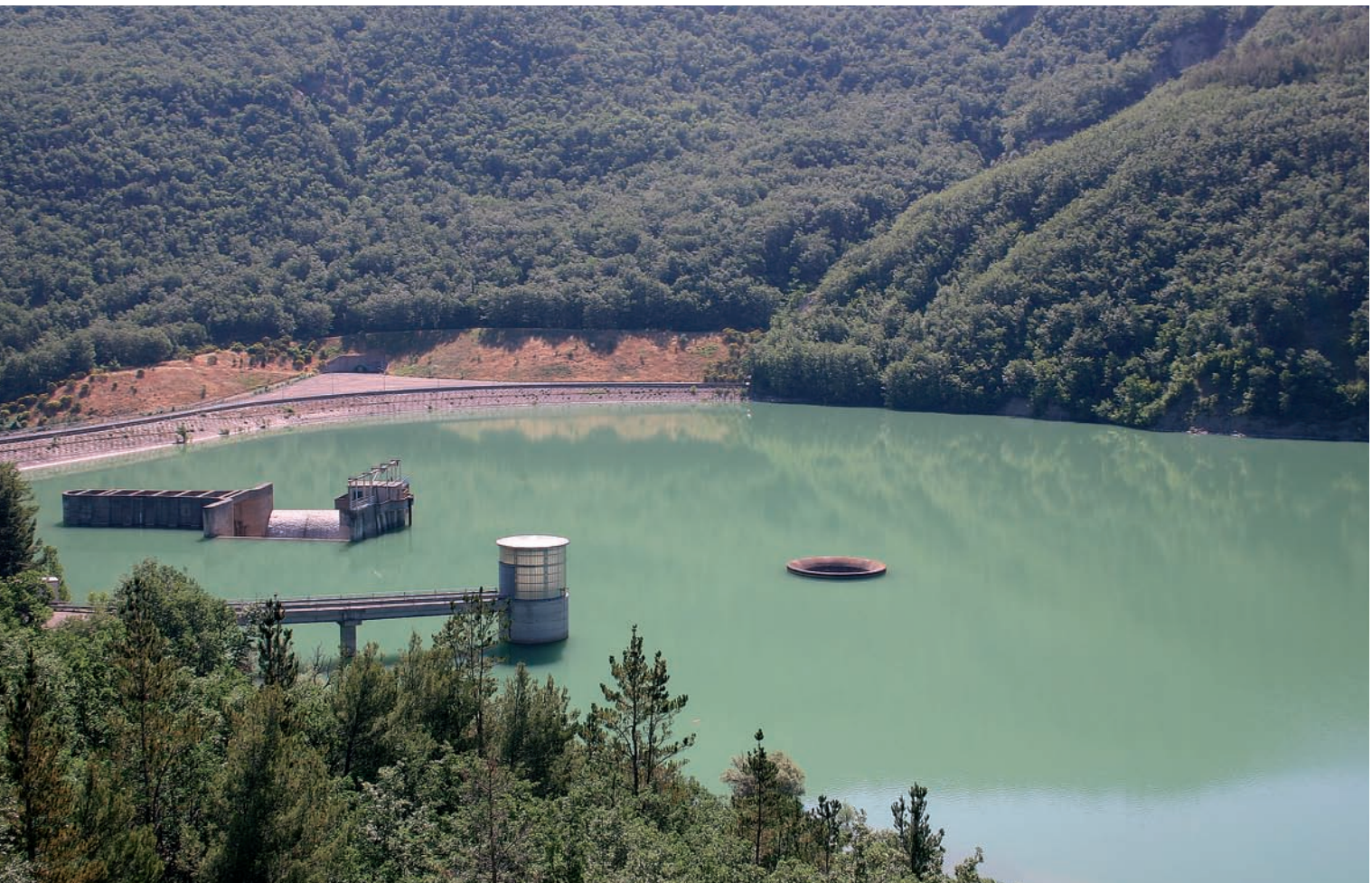
Invaso della Camastra, veduta panoramica (foto Adb)
