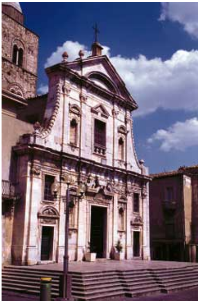
Melfi (Pz): Cattedrale (Foto Ottavio Chiaradia)
