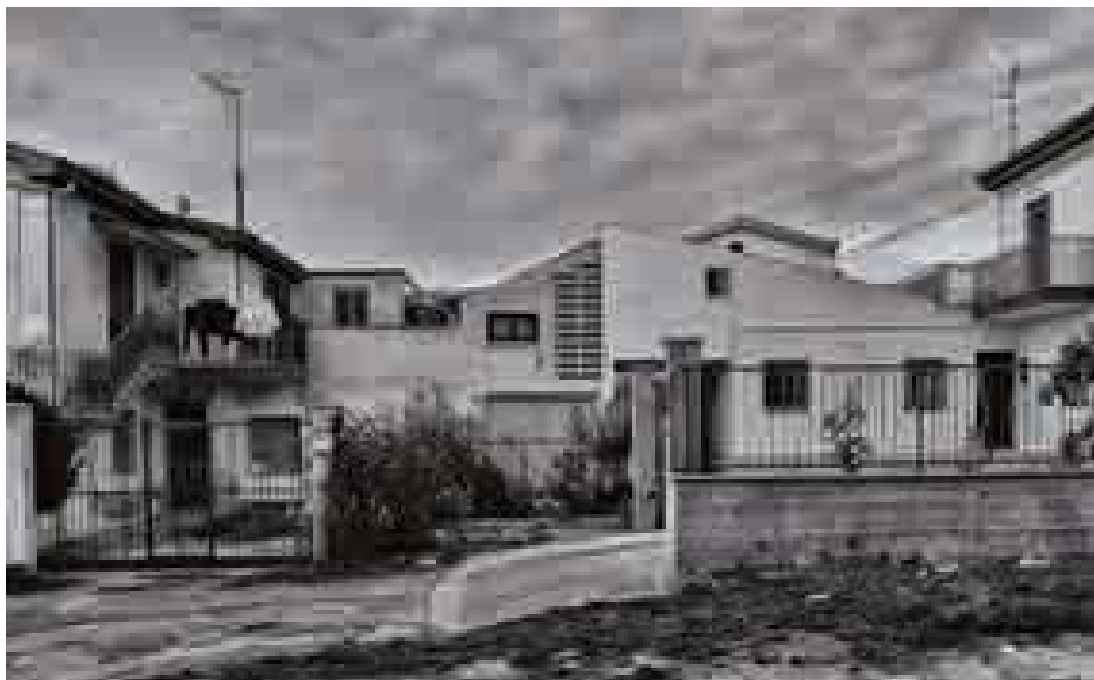
Fig.4.59 Nuovi interventi di trasformazione delle case per contadini del borgo La Martella, 2011. La stalla persa la sua primaria funzione è stata trasformata in rimessa o in nuove stanze per le abitazioni. Sulla sinistra si può notare una scala che collega il primo piano dall'esterno; sulla destra l'aggiunta di un balcone.
