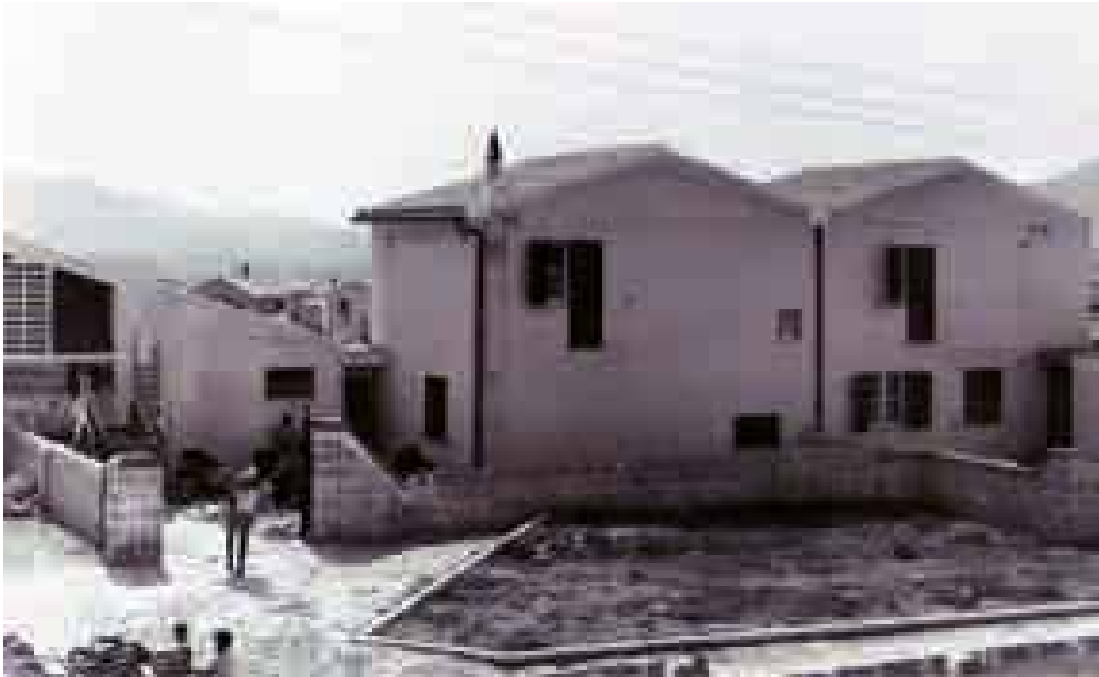
Fig.4.57 Veduta di una strada con le abitazioni per contadini. La foto è stata scattata a pochi anni dalla edificazione del borgo. Si possono ancora osservare gli interventi di manutenzione realizzati in copertura, con le nuove tegole di tono più chiaro e la soletta a sbalzo con l'intonaco appena realizzato.
